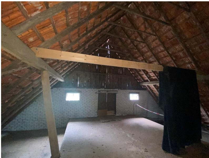
Afb. Gave kapconstructie gezien richting de achterzijde van de schuur.
