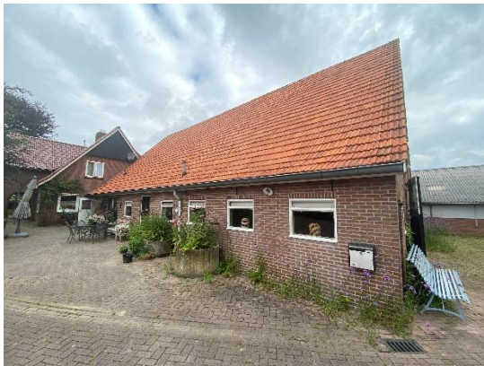
Zuidgevel van de schuur
