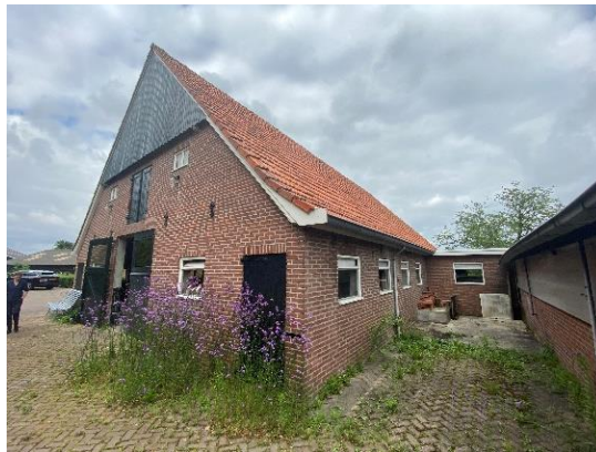
Oostgevel van de schuur
