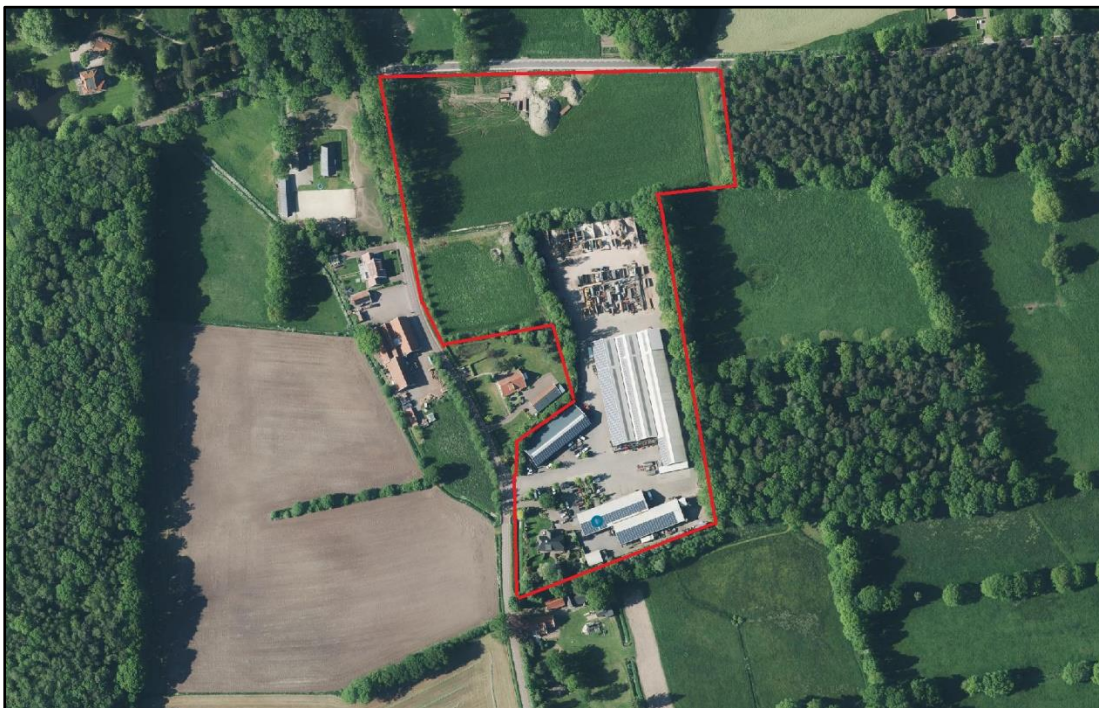
Afbeelding 2.1 Luchtfoto plangebied huidige situatie (Bron: PDOK, bewerkt)
