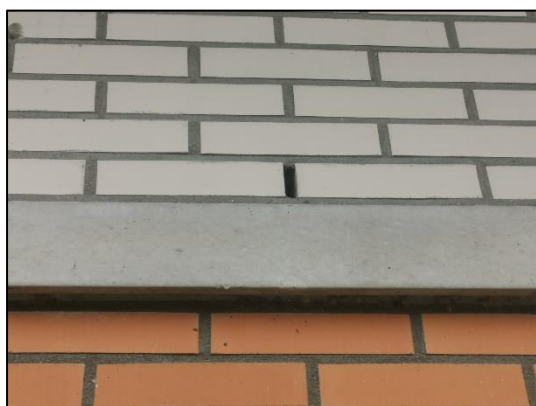
Figuur 1.6: Het gebouw beschikt over stootvoegen.
