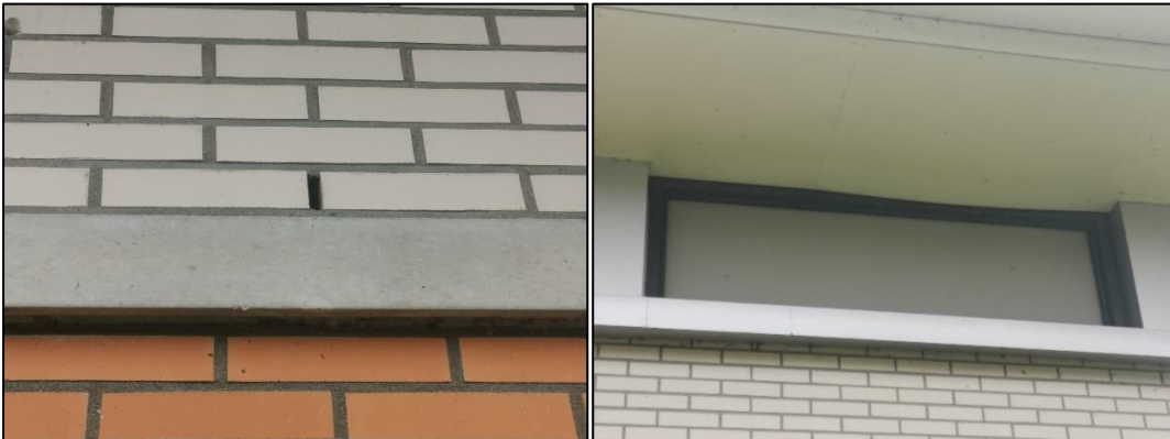
Figuur 2.12 en 2.13: Voorbeelden van mogelijke vleermuisverblijfplaatsen. Links een stootvoeg en rechts een losgekomen paneel.
