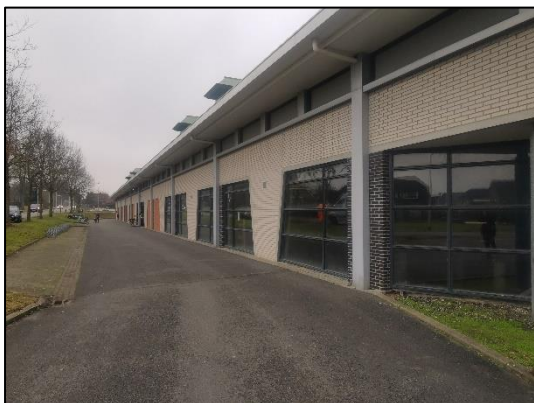
Figuur 2.7: Zuidaanzicht van het gebouw.
