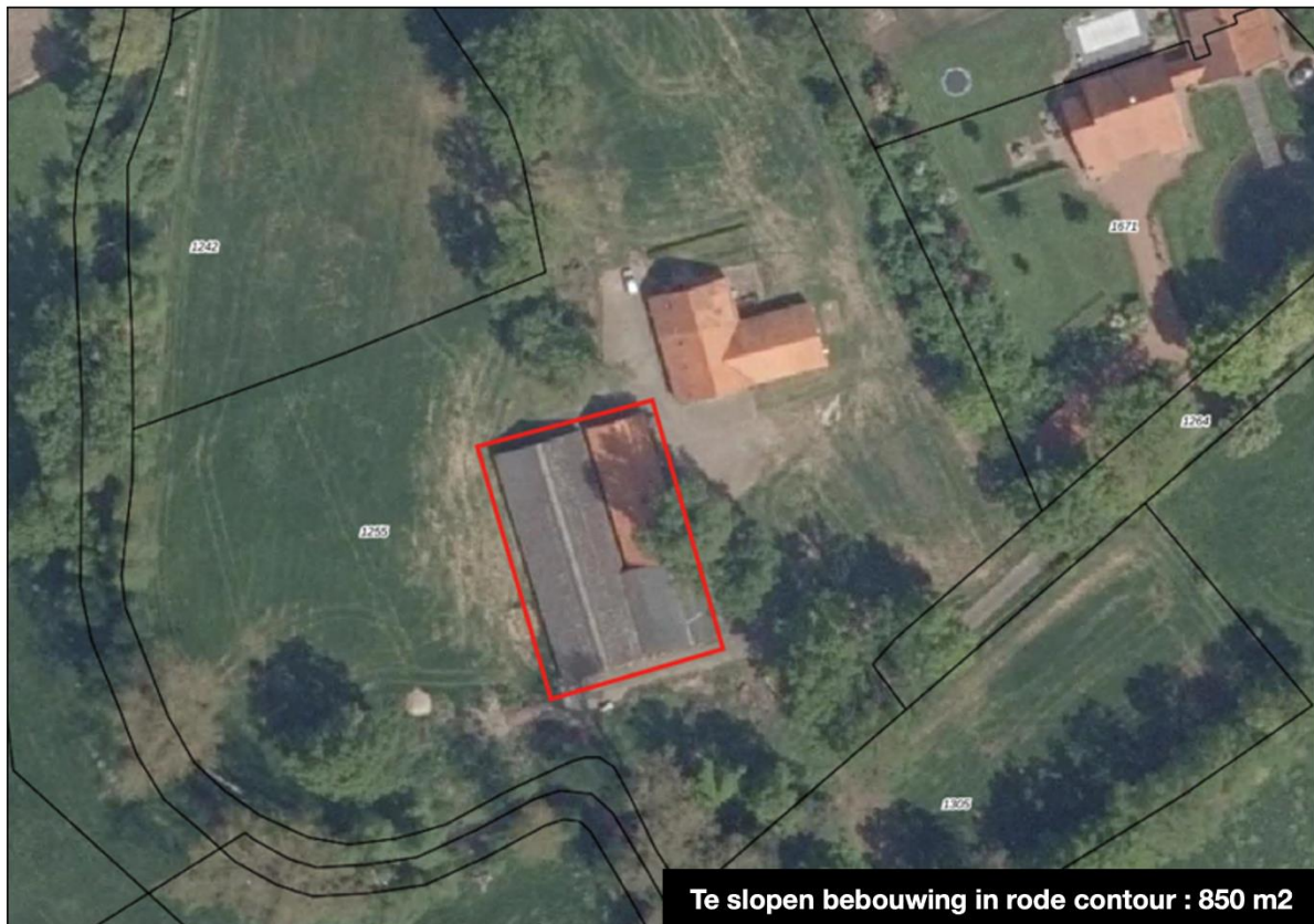
Afbeelding 3.1 Overzicht te slopen bebouwing (Bron: BJZ.nu)
