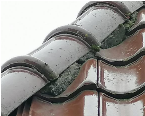
Gevelpannen liggen in cement waardoor er geen openingen ontstaan welke als potentiële nestlocatie voor gierzwaluw kunnen dienen.
