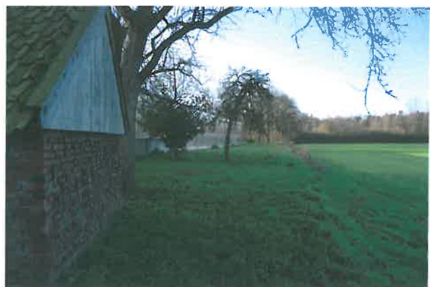
Hoogteverschil, opgevangen met talud
