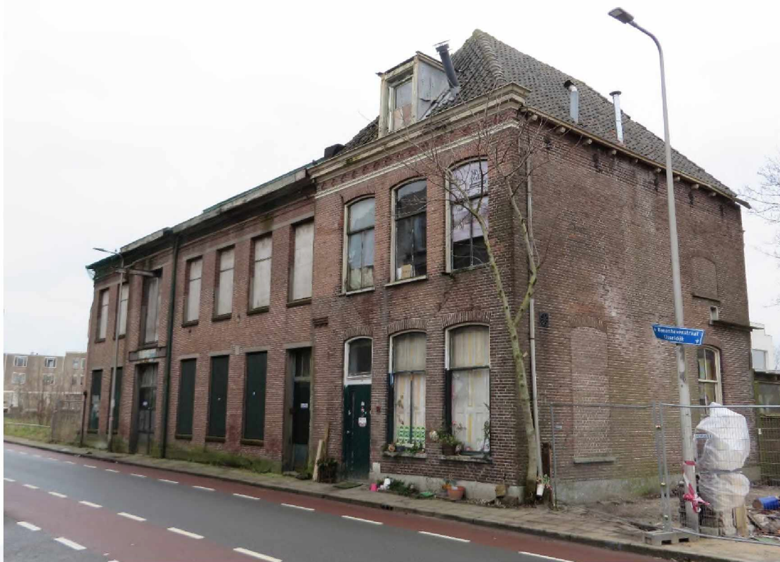
Foto 1. Vooraanzicht van de panden aan de bovenhavenstraat 8, 10 en 12. Nummer 12 (de woning) wordt gesloopt.
