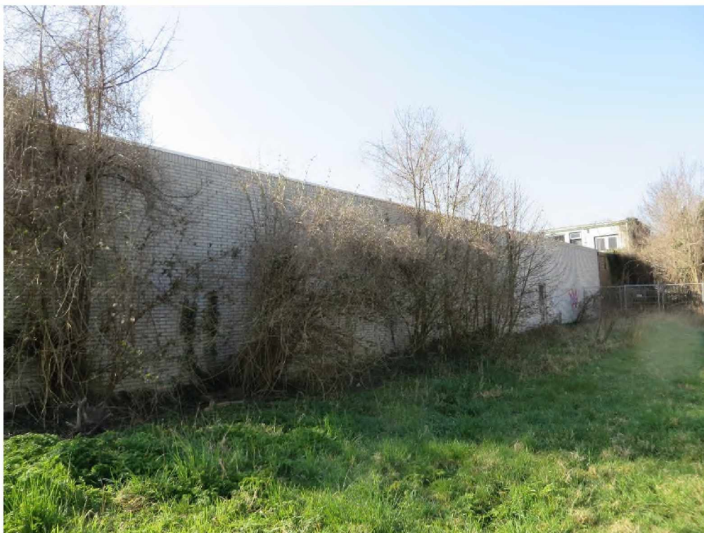
Foto 11. Achterzijde van IJsseldijk 2-I, 2A en 4. Deze locatie is braakliggend en kent veel groen bestaande uit gras, diverse kruiden en een aantal struiken.
