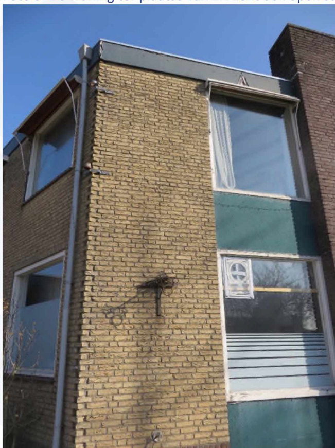
Foto 4. Een zijaanzicht van het IJsseldijk 4. Aan deze zijde geen open stootvoegen maar wel gevelbetimmering met kieren bij het dak.
