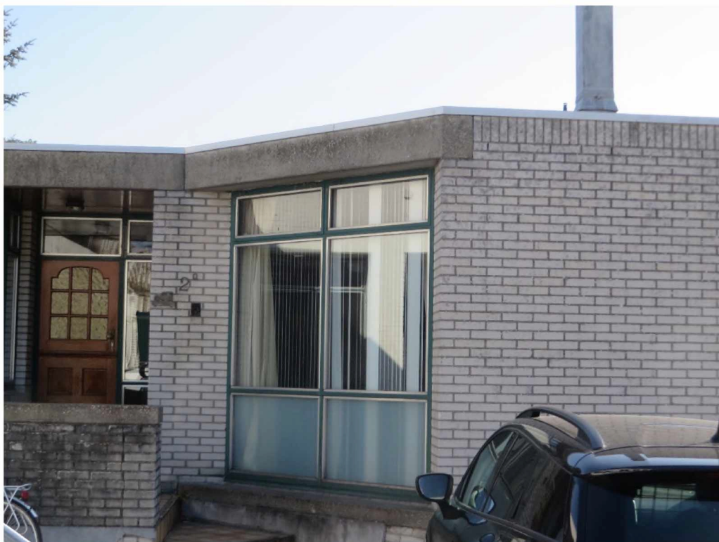
Foto 3. De woning ter plaatse van 2A kent ook open stootvoegen en daklijsten.
