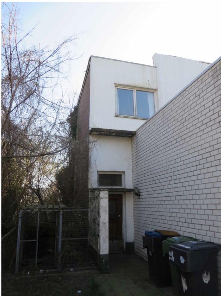
Foto 12. Achterzijde van IJsseldijk 2-I. Aan deze zijde is klimop aanwezig aan de buitenmuur.
