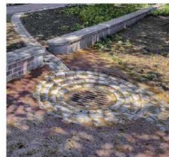
De waterkolk: zichtbare waterloop
