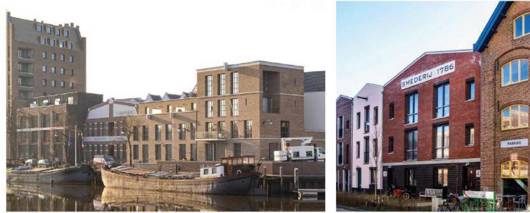
Bouwmassa Geschakelde industriële panden aan de kadewand
