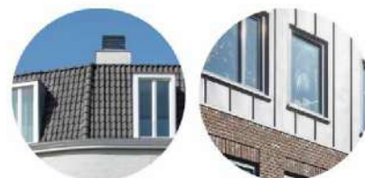
Antracietgrijze keramische dakpannen of bijvoorbeeld geprofileerd staal
