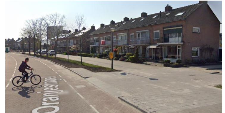
Uitritconstructie op de Oranjesingel (Google Streetview)
