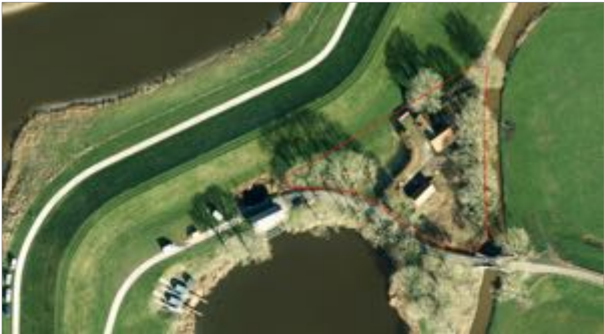
Figuur 2.1 | Situering onderzoeksgebied (rode lijn) met omliggende context. De luchtfoto is enigzinds gedateerd; de binnen het onderzoeksgebied weergegeven bebouwing is niet meer aanwezig. (bron ondergrond: ArcGis.com)
