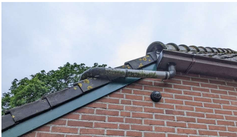
Dak buitenzijde, open nokvorsten
