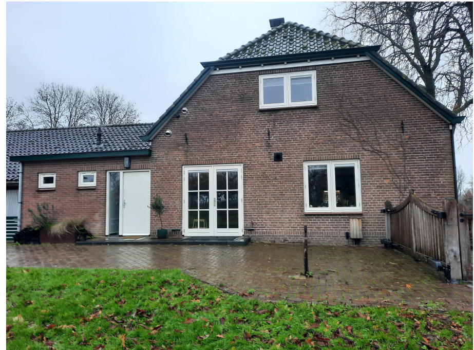
linker zijgevel - voorhuis en uitbouw
