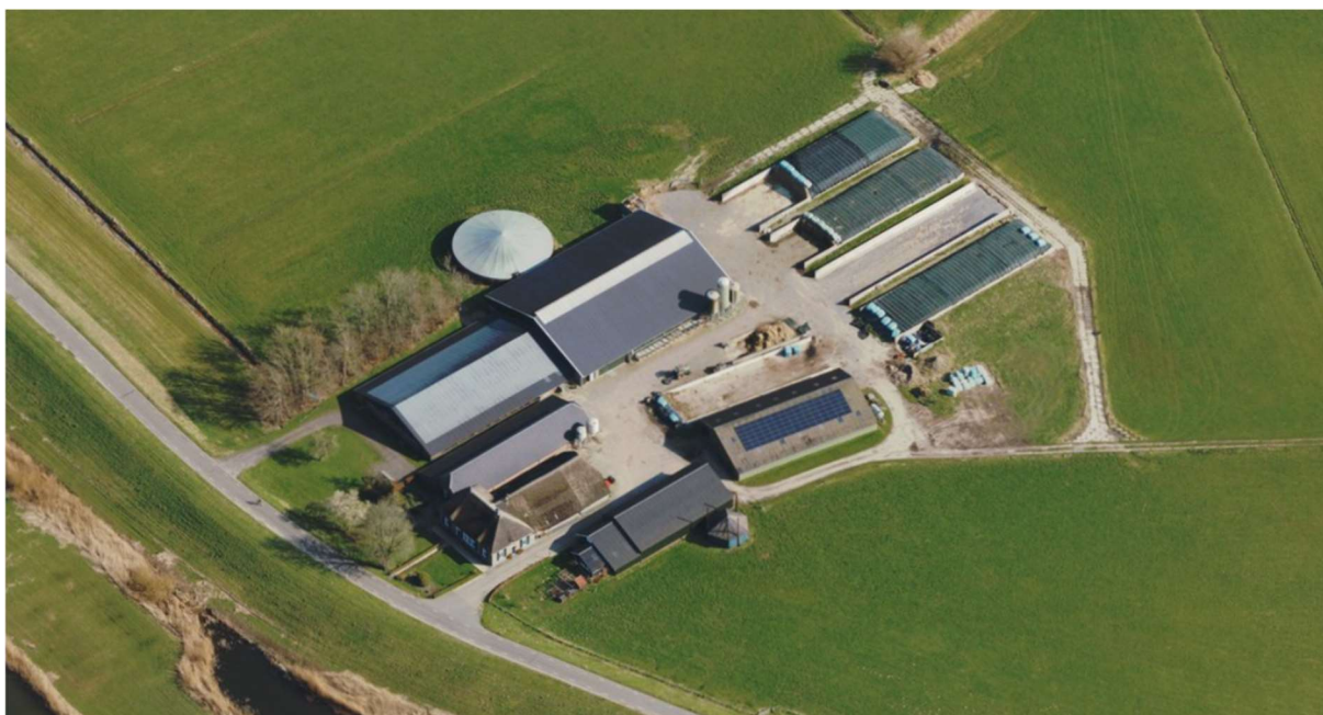
Afbeelding, bouwlocatie Zalkerdijk 19 (Bron: Street Smart, 5 maart 2022)
