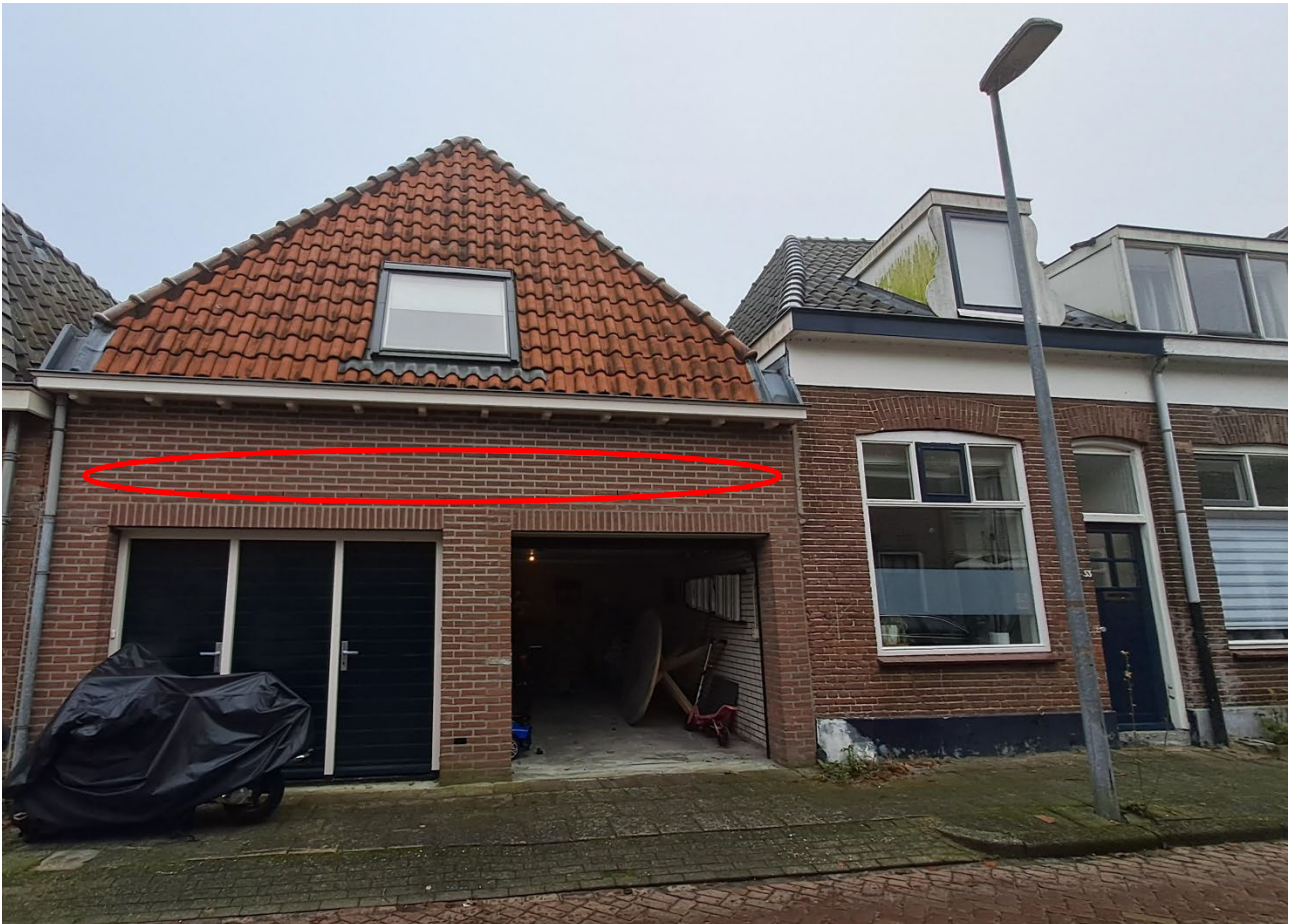
Afbeelding 6.1: Projectgebied met open stootvoegen, die mogelijk toegang geven tot de spouwmuur (rood kader).
