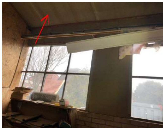
Plafond- en wandbeplating
