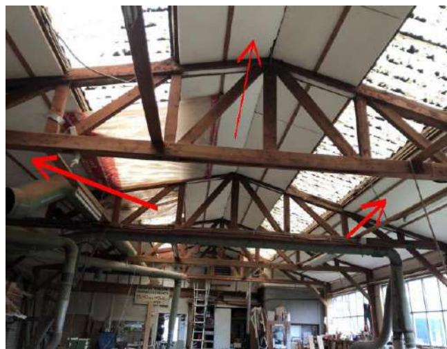
Plafond- en wandbeplating
