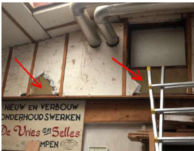
Plafond- en wandbeplating
