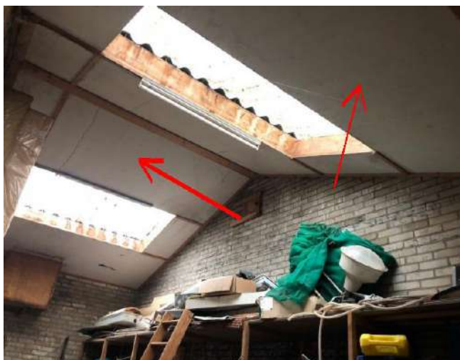
Plafond- en wandbeplating
