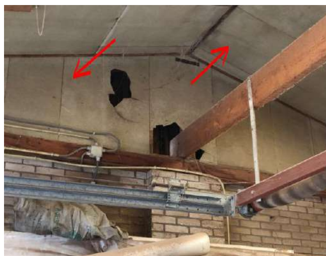
Plafond- en wandbeplating
