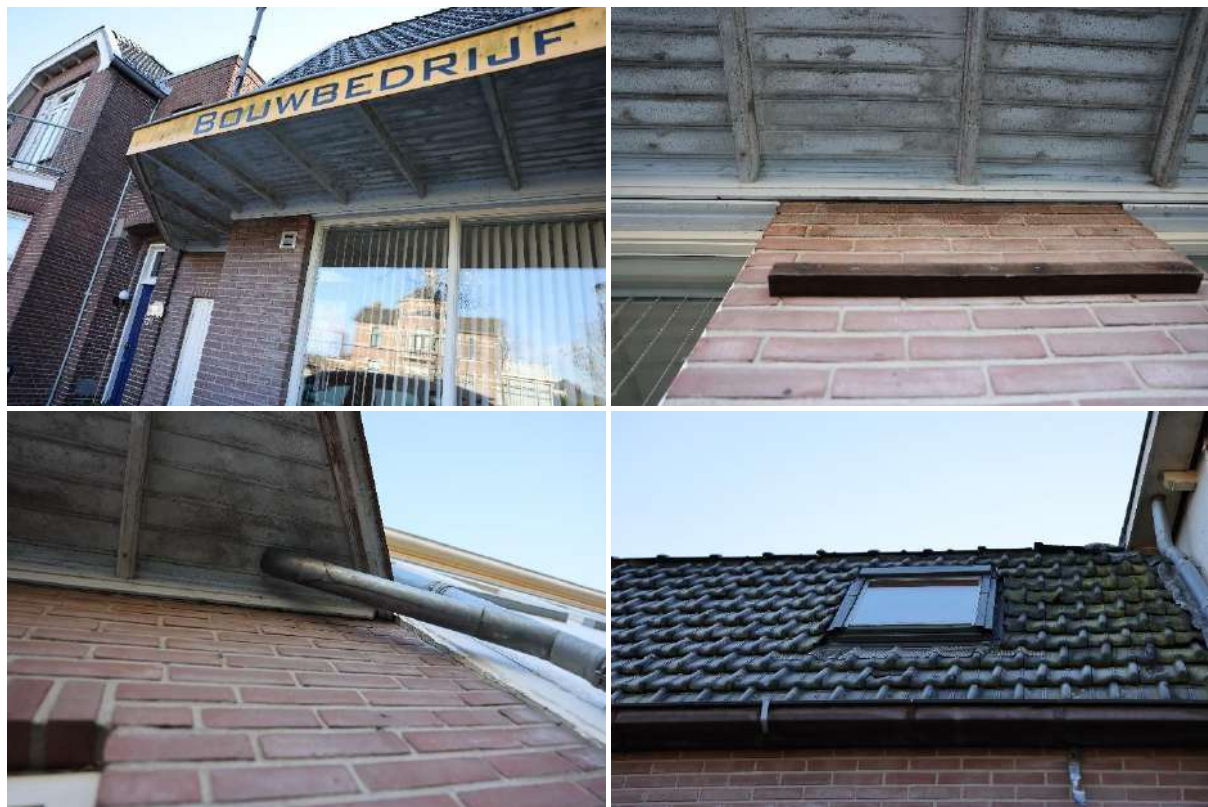
Figuur 12 Verwarmd gedeelte (Deel 1) van de te slopen panden. Dit pand biedt echter geen potentie voor vleermuizen, omdat alles goed afgedicht is. Er zijn geen ruimtes tussen materiaalovergangen, dakpannen of loodslabben, die groot genoeg zijn voor vleermuizen om achter weg te kruipen. Hierdoor kunnen vleermuizen de spouwmuur en/of het dakbeschot niet bereiken. Foto's Bureau Biota.
