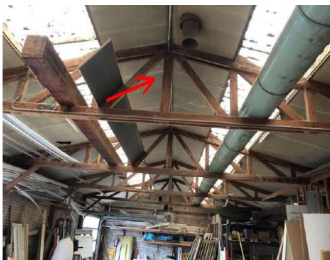
Plafond- en wandbeplating
