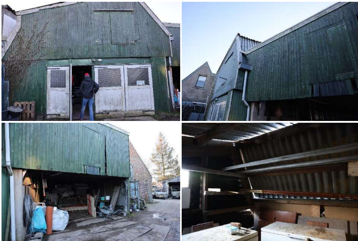
Figuur 10 Deel 6, de schuur met houten beplating en het golfplaten dak. Deze bouwwijze en het binnenklimaat nodigen huismussen niet echt uit tot broeden op deze locatie. Er zijn geen sporen van huismussen of nesten van andere vogels in dit pand gevonden. Foto's: Bureau Biota.
