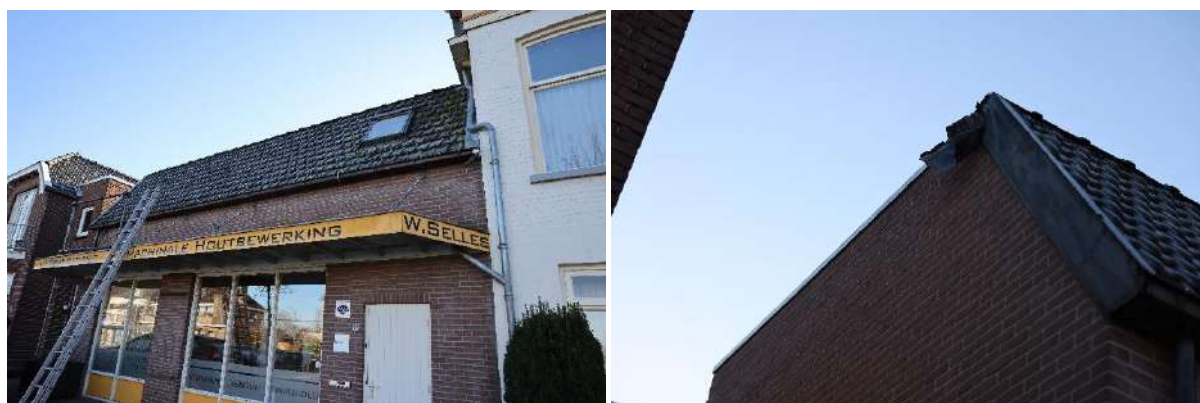
Deel 1: Verwarmd pand, voormalig woonhuis. . Foto's Bureau Biota.
