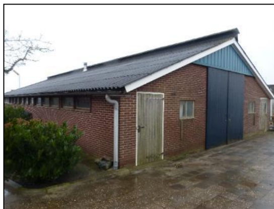
Afbeelding 2.11. Oude koeienstal gezien vanaf west.
