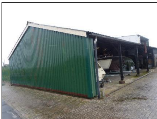
Afbeelding 2.8. Kapschuur vanuit zuidoost.
