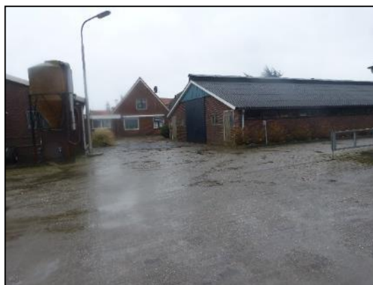
Afbeelding 2.13. Schuren (links en rechts) met woonhuis (midden) gezien vanaf het westen.
