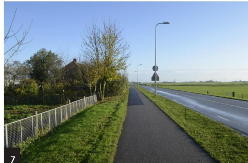
Zicht vanaf de Hagedoornweg t.h.v. de woning op nr 2.
