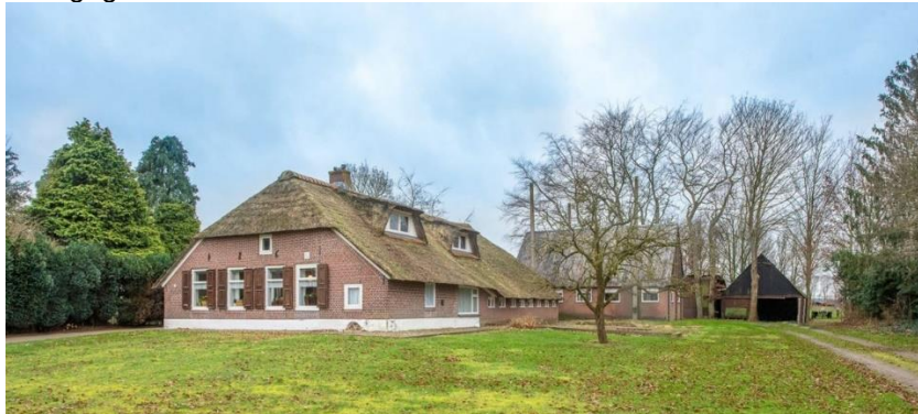
Afbeelding: Zicht op de voorzijde van de woning en achter liggende schuren vanaf de weg.
