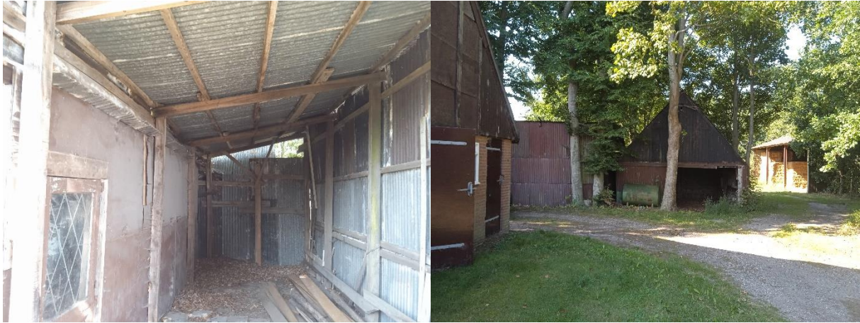
Foto links; de te slopen schuren zijn voor vogels toegankelijk en geschikt om in te nestelen. Foto rechts; Vogels kunnen een nestplaats bezetten in de beplanting (o.a. aangrenzend aan de te slopen schuren).
