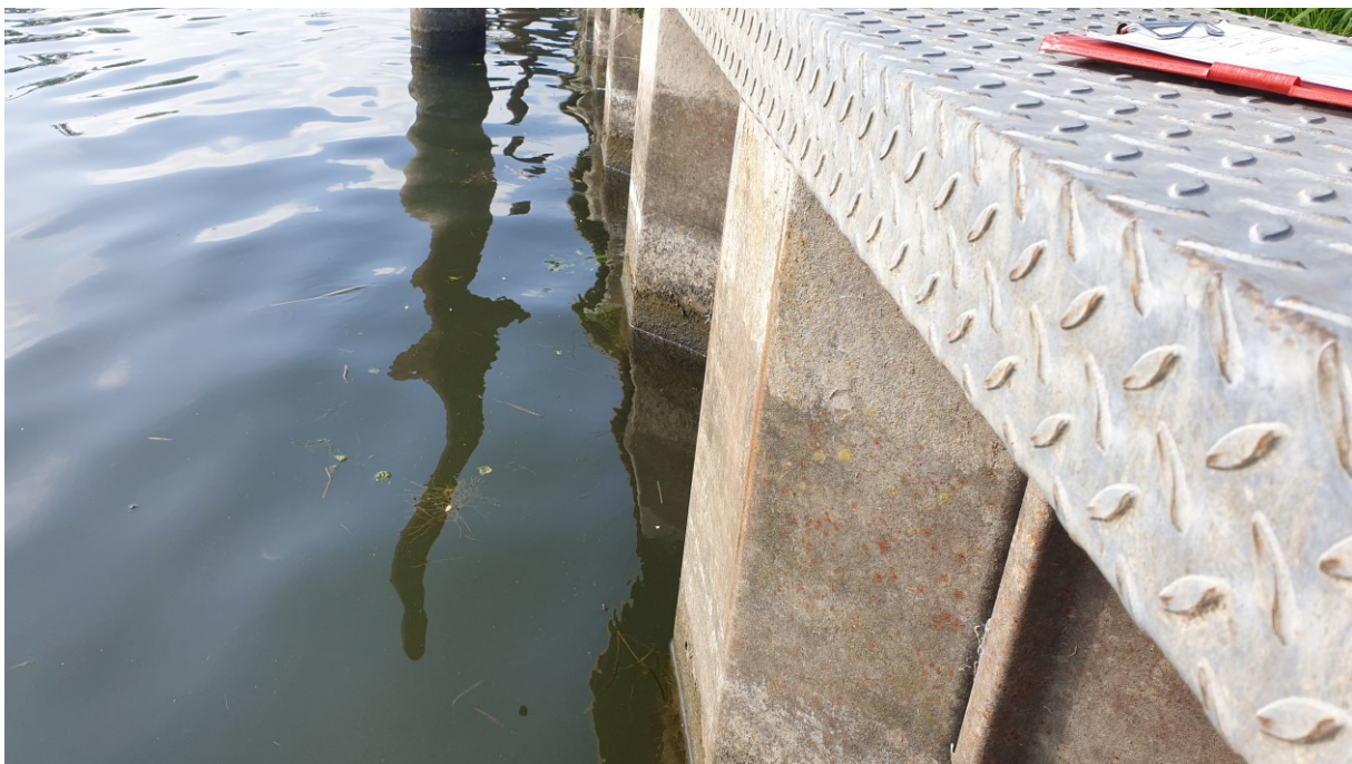
Figuur 1.5 De wal/oever is voorzien van walbeschoeiing.
