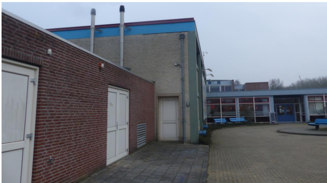
Foto 2 De binnenplaats van het gebouw.
