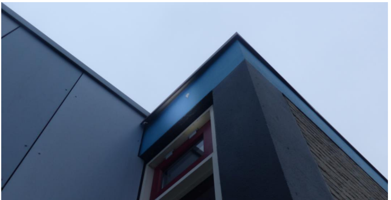
Foto 3 Geschikte invlieglocaties voor vleermuizen in open naden tussen de gebouwonderdelen (boven) en onder de dakrand (onder).
