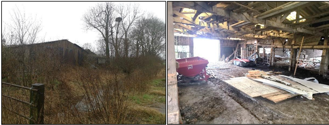
Figuur 2.7 (links): Achterzijde van de hooiberg met sloot. In een van de bomen, links bovenin de afbeelding, is een ooievaarsnest zichtbaar; Figuur 2.8 (rechts) Binnen aanzicht van een van de schuren. Er liggen bouwmaterialen, puinhopen en overige materialen en een deel van de muren en daken is ingestort.
