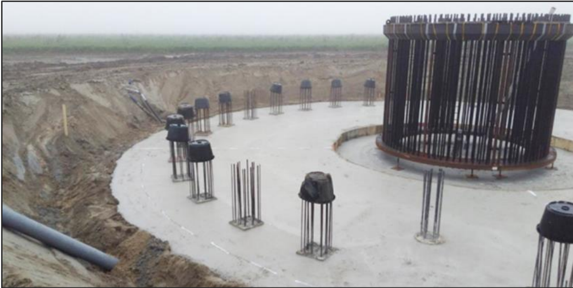
Figuur 3.3 Ankerkooi en wapeningsstaal heipalen (voorbeeld)
