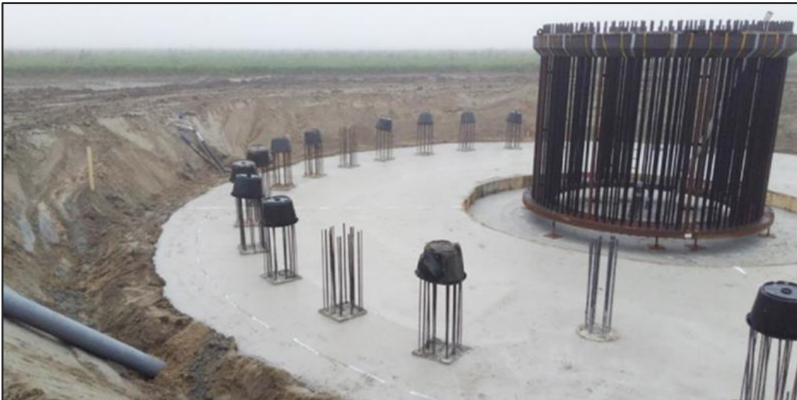
Figuur 3.3 Ankerkooi en wapeningsstaal heipalen (voorbeeld)
