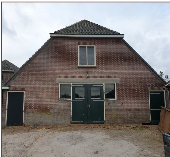
Afb. 2.1: Vooraanzicht van de te verbouwen veeschuur. De schuur blijft behouden maar wordt omgevormd naar woning. Het dak zal vervangen worden en er wordt een muur voor de binnenmuur geplaatst.
