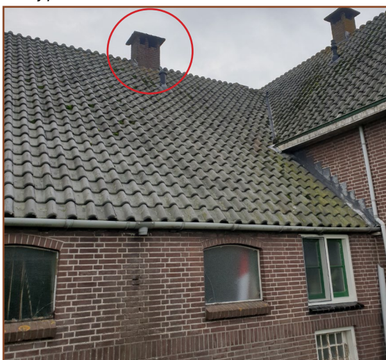
Afb. 2.5: De schoorsteen van de aanwezige rookoven. Door de rookoven is de schuur geschikt als broedlocatie voor kauw. Nesten ontbreken echter. Ook kan door de schoorsteen marterachtigen of uilen de zolder gebruiken.
