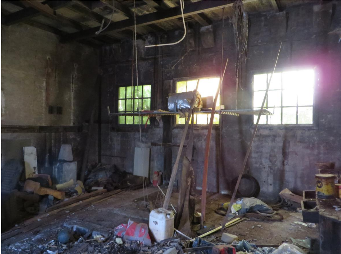
Foto 12. In het achterste gedeelte van Veerweg 38 is een leegstaande ruimte dat vermoedelijk een oude smederij was.
