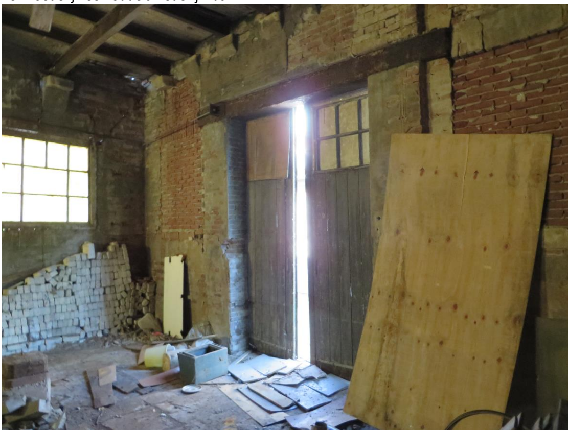
Foto 13. In het achterste gedeelte van Veerweg 38 is een leegstaande ruimte dat vermoedelijk een oude smederij was.
