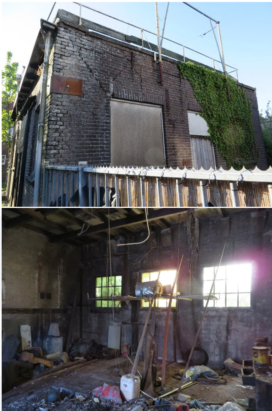
Figuur 2.4 Achterste deel van de woningen (oude smederij) van buiten en van binnen.
