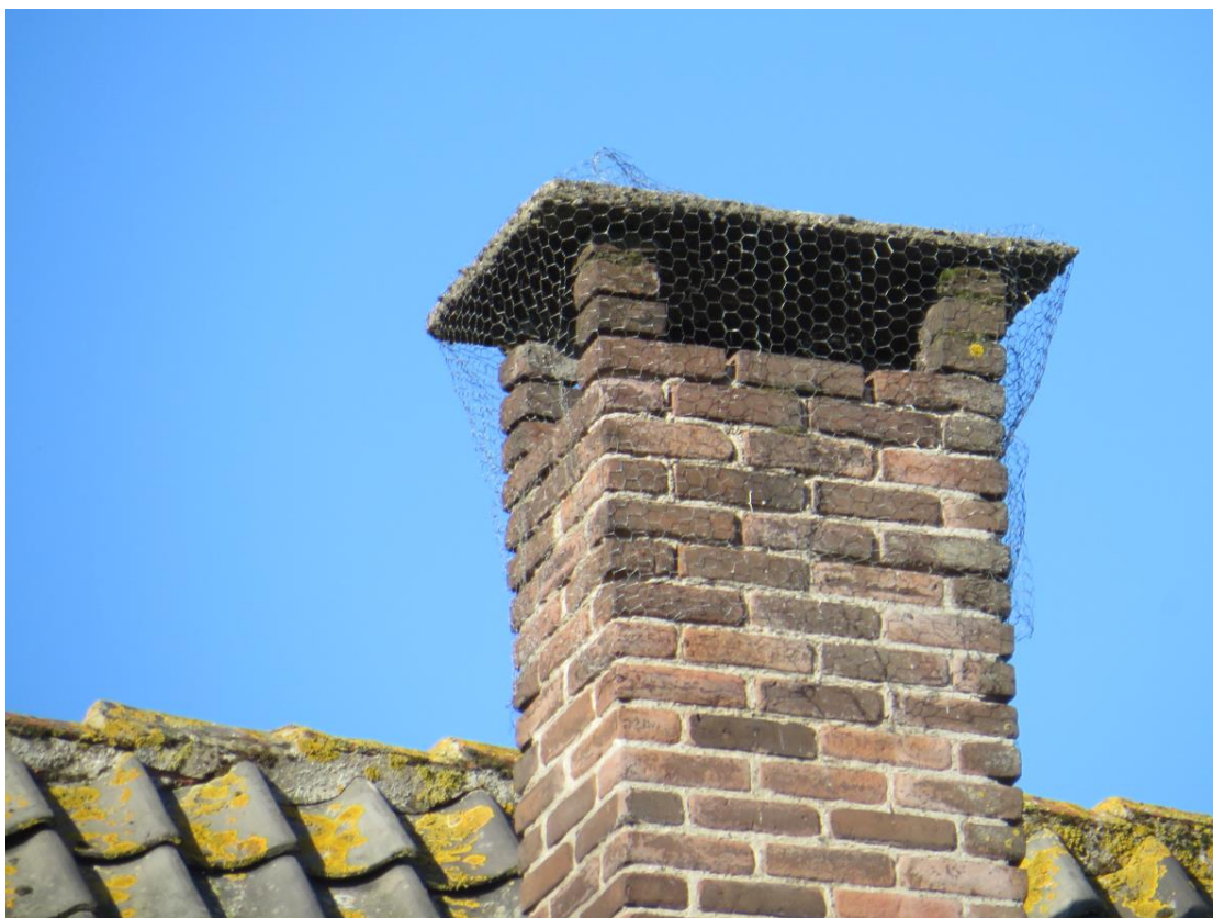
Foto 9. Schoorsteen afgedekt met gaas.
