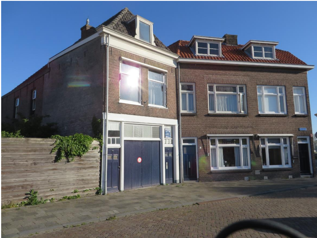
Foto 1. Voorzijde van het pand. Op het eerste zicht: oude panden, oude dakpannen.
