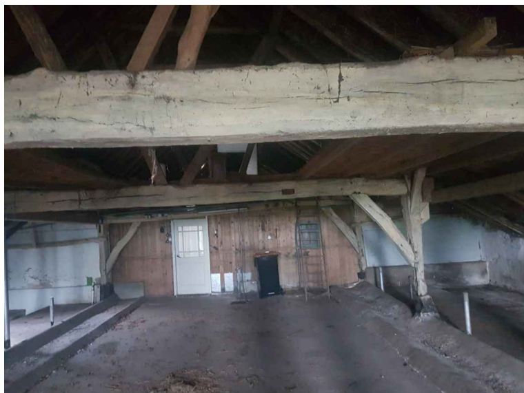
FOTO 0-01 bokspanten ernstig aangetast door houtworm en boktor
