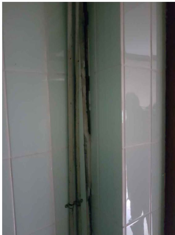
FOTO 0-08 scheur ±30 mm
