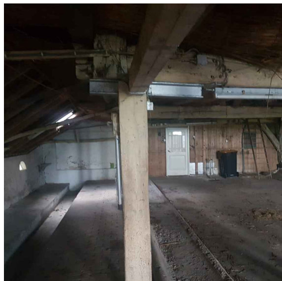
FOTO 0-02 stalen ondersteuning in bokspant
