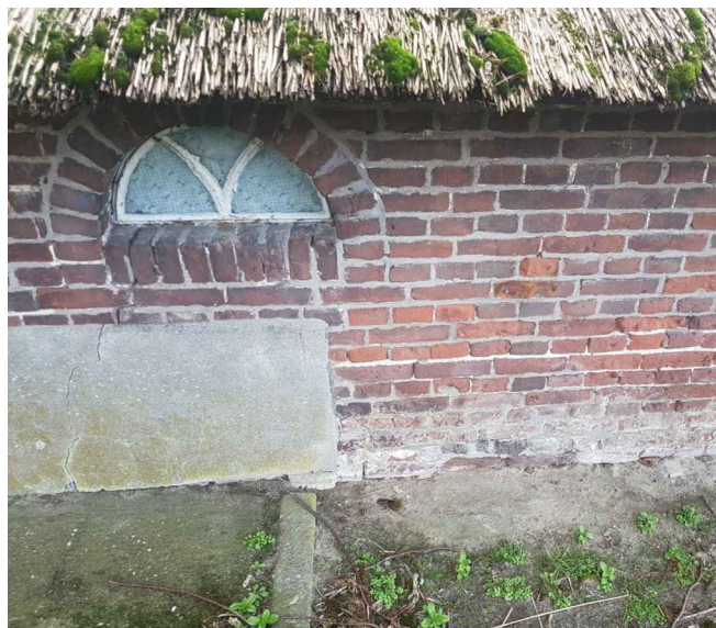
FOTO 21 scheur in metselwer en lambrizing
