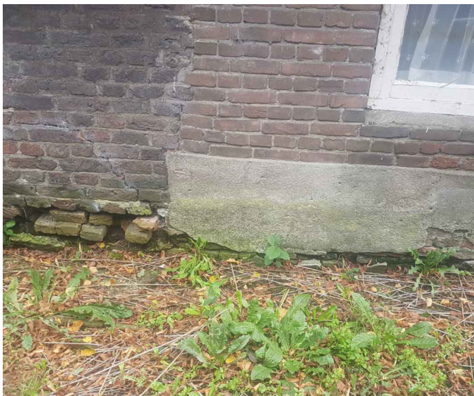
FOTO 07 los metselwerk tpv fundering
