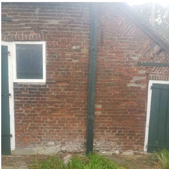
FOTO 14 stutwerk houten balk tpv achtergevel
