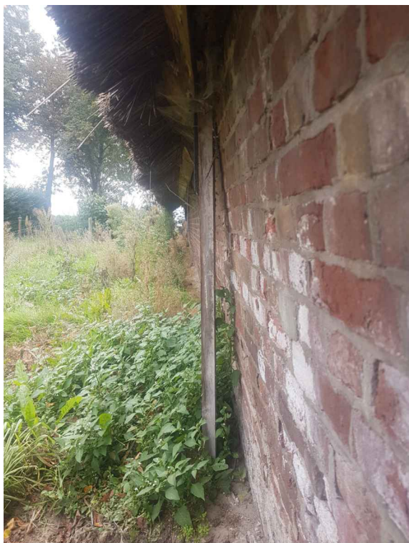
FOTO 18 stutwerk tpv zijgevel tegen uitzakken
