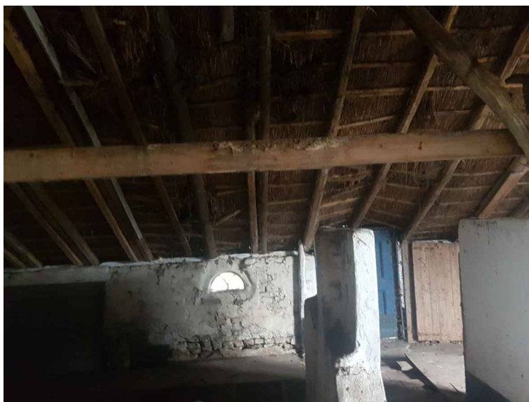
FOTO 0-04 sporen aangetast door houtworm en boktor
