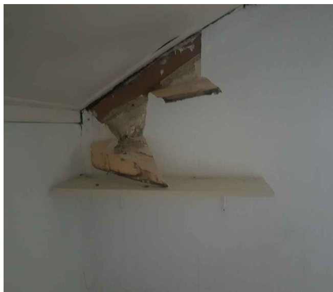
FOTO 0-16 zijgevel uitgezakt tpv voorgevel, scheur \pm 30 mm
