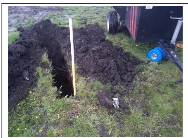
Foto: Inspectiesleuf D01-05
