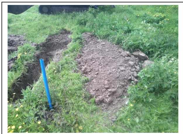
Foto: Inspectiesleuf C02-04
