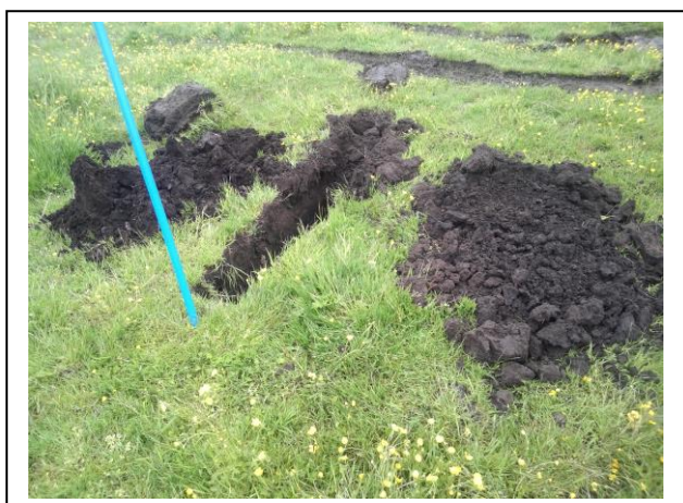
Foto: Inspectiesleuf D03-01
