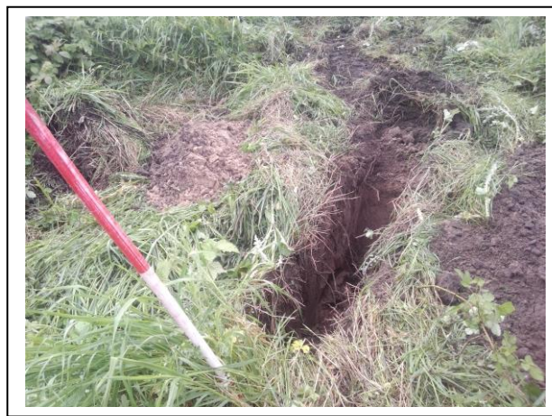
Foto: Inspectiesleuf C01-02
