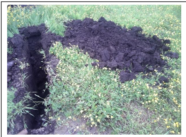
Foto: Inspectiesleuf D03-05
