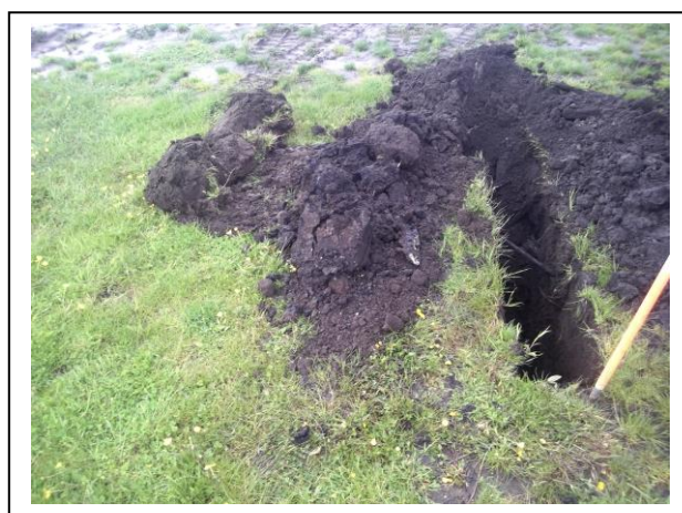
Foto: Inspectiesleuf D01-05
