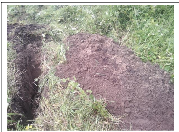
Foto: Inspectiesleuf C01-02
