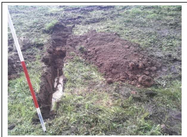
Foto: Inspectiesleuf C02-02
