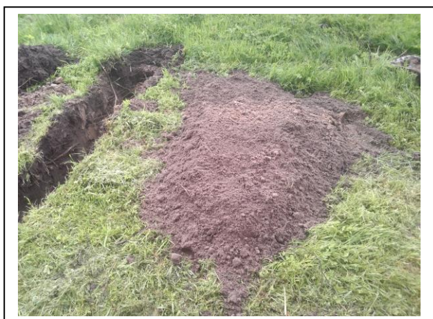
Foto: Inspectiesleuf D01-07
