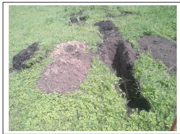
Foto: Inspectiesleuf D01-07
