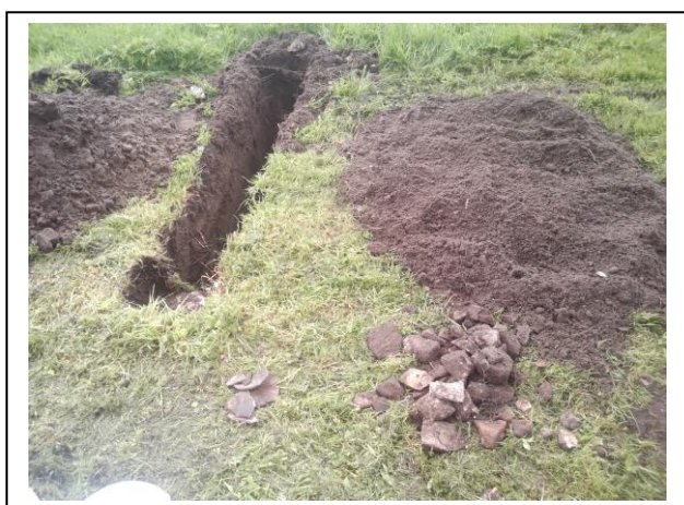
Foto: Inspectiesleuf D01-07
