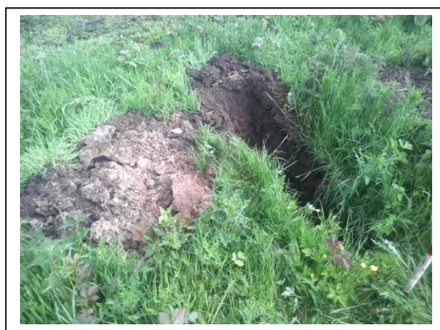
Foto: Inspectiesleuf C02-03
