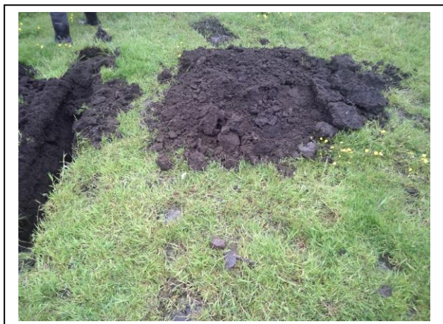
Foto: Inspectiesleuf D01-03
