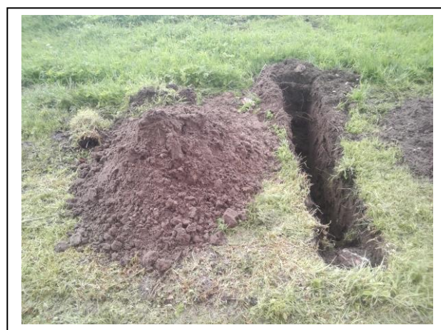
Foto: Inspectiesleuf D01-07
