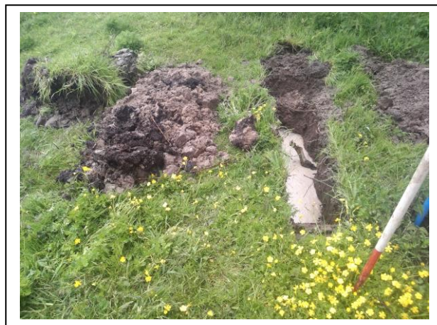
Foto: Inspectiesleuf C02-04
