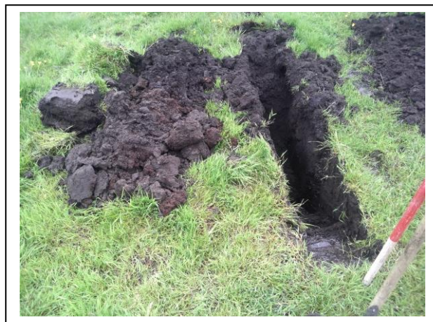
Foto: Inspectiesleuf D01-03
