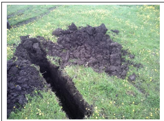
Foto: Inspectiesleuf D02-05
