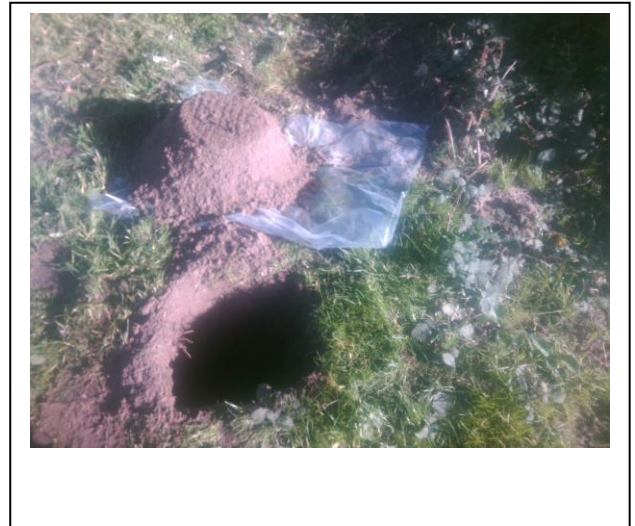
Foto: Inspectiegat C34
