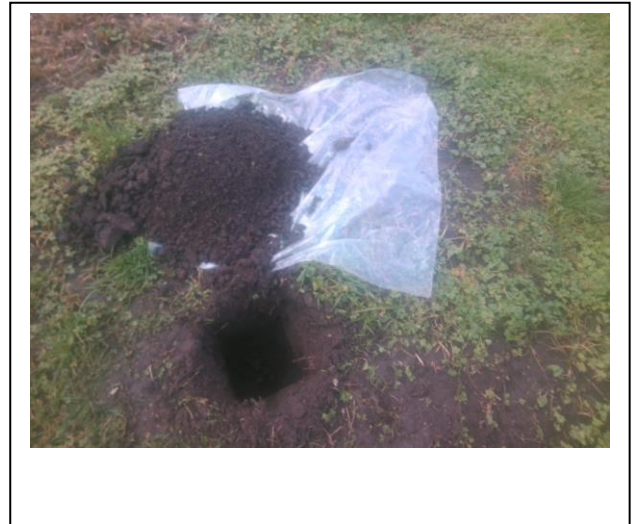
Foto: Inspectiegat D22
