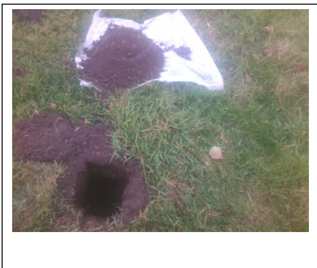
Foto: Inspectiegat B05
