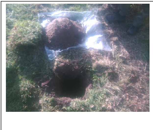
Foto: Inspectiegat C13
