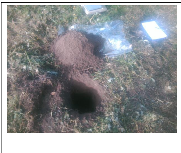
Foto: Inspectiegat C35
