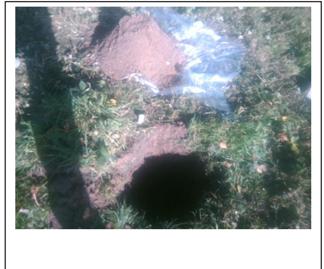
Foto: Inspectiegat C32
