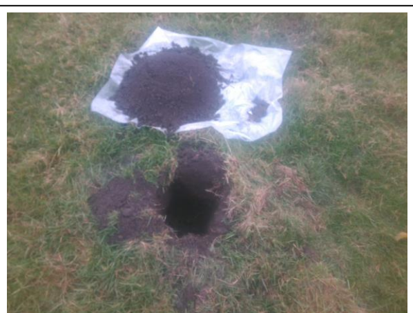
Foto: Inspectiegat B12
