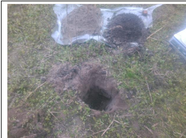
Foto: Inspectiegat D07
