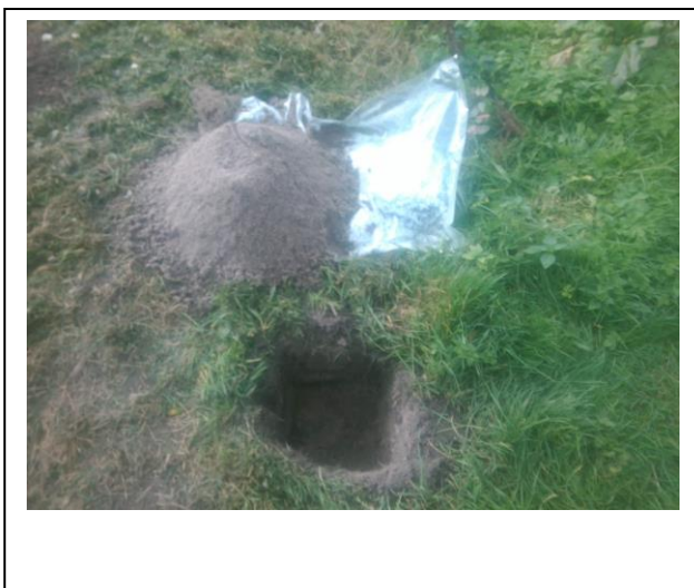
Foto: Inspectiegat C41
