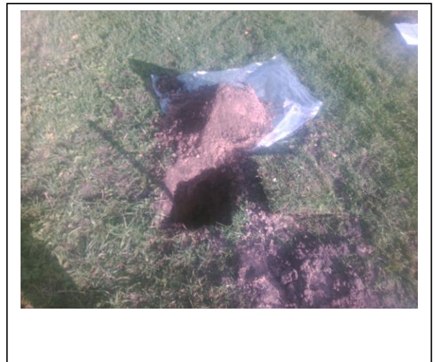
Foto: Inspectiegat C14
