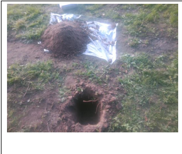
Foto: Inspectiegat C37
