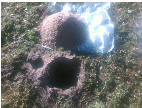
Foto: Inspectiegat C27
