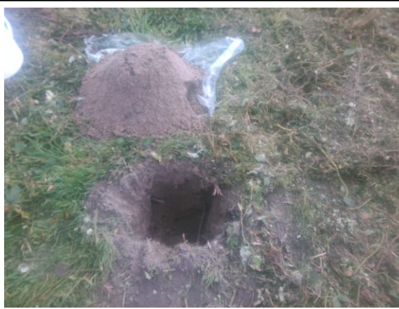
Foto: Inspectiegat C04
