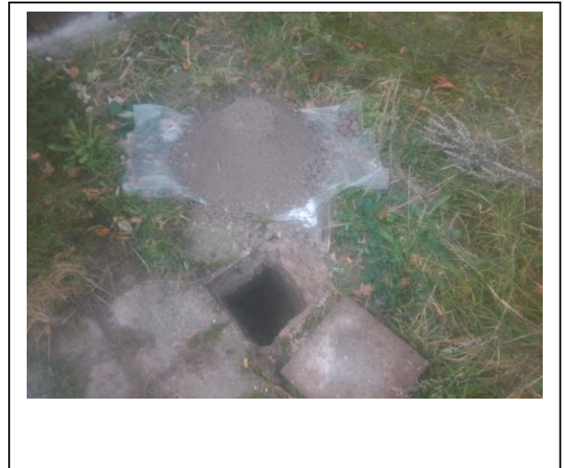
Foto: Inspectiegat A04
