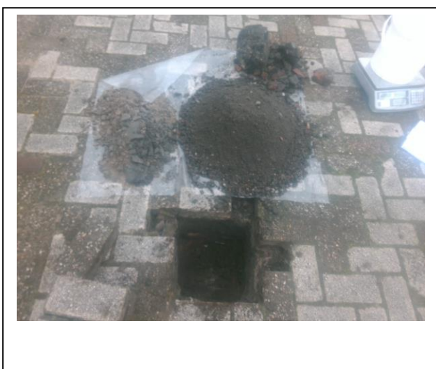
Foto: Inspectiegat D05
