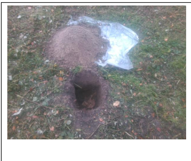
Foto: Inspectiegat C11
