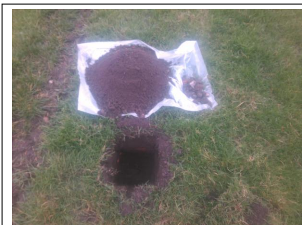
Foto: Inspectiegat B11
