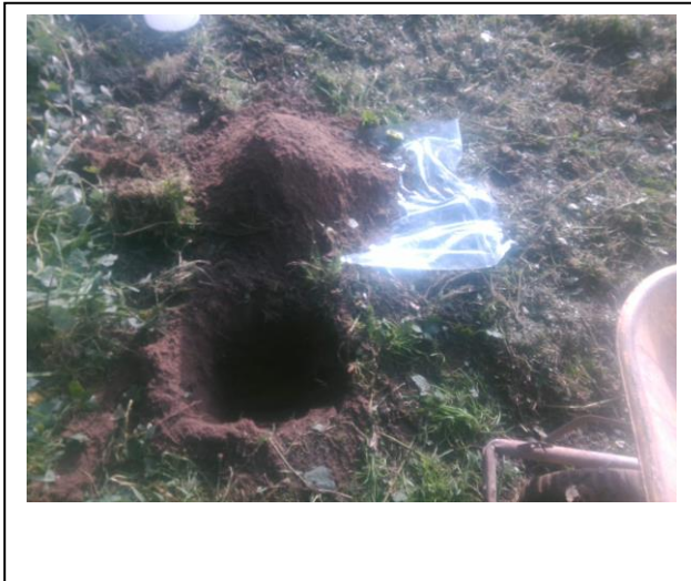
Foto: Inspectiegat C39
