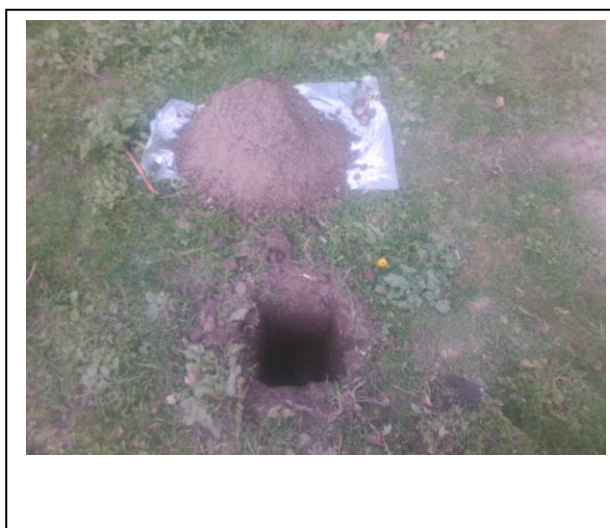
Foto: Inspectiegat C22
