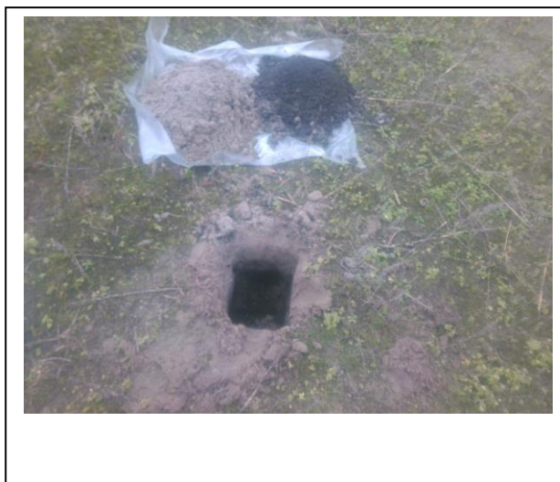
Foto: Inspectiegat D18
