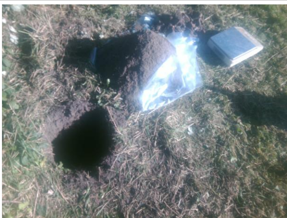
Foto: Inspectiegat C29
