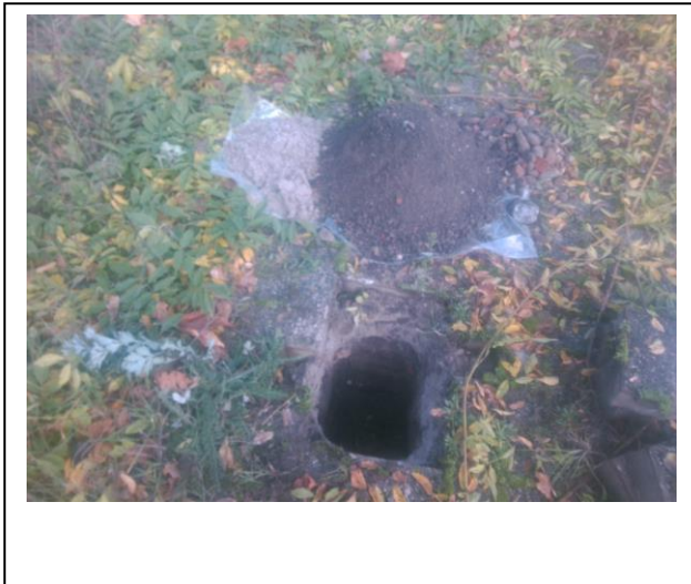
Foto: Inspectiegat A01
