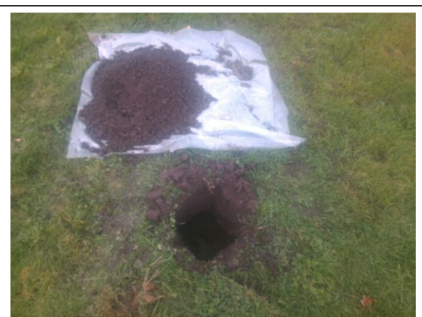
Foto: Inspectiegat D12
