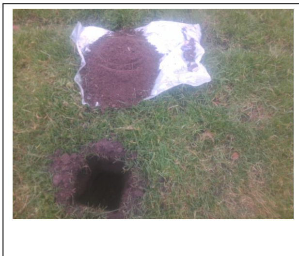
Foto: Inspectiegat B04
