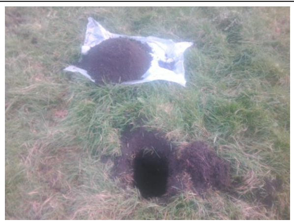
Foto: Inspectiegat A16
