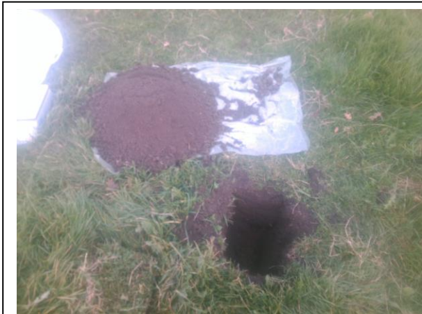
Foto: Inspectiegat A15
