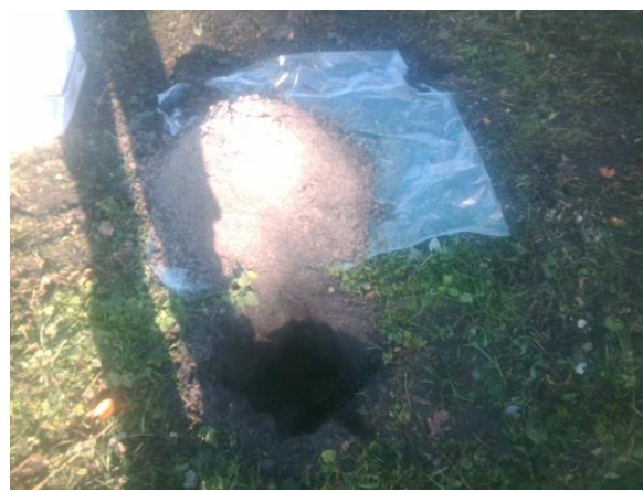
Foto: Inspectiegat C28
