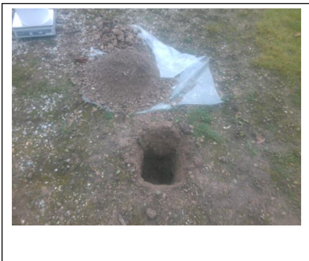
Foto: Inspectiegat D01
