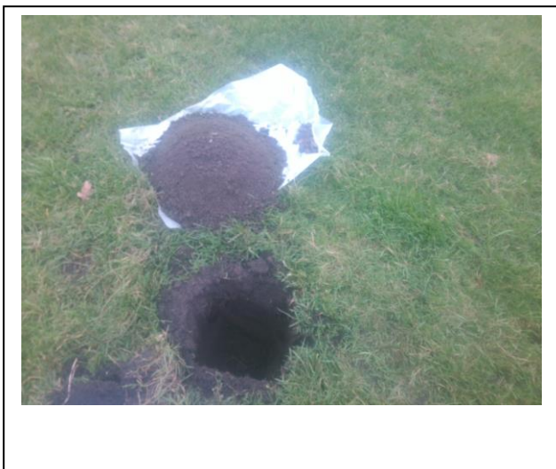
Foto: Inspectiegat B01
