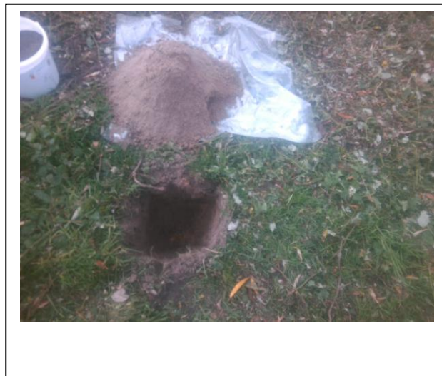
Foto: Inspectiegat C10
