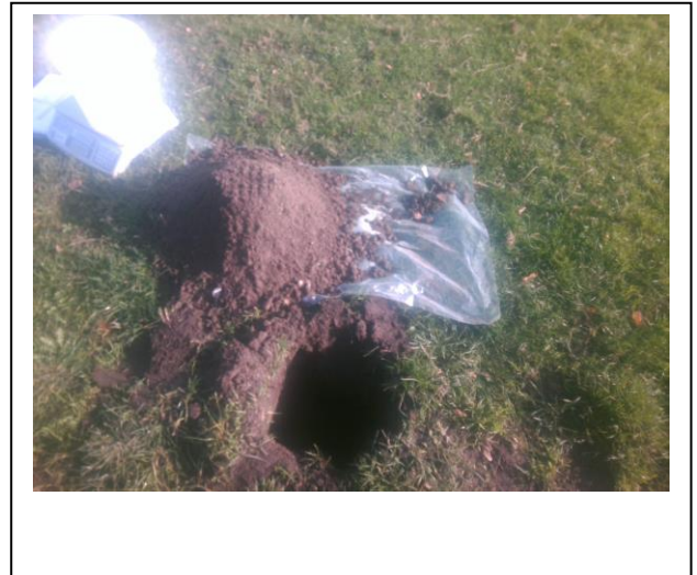
Foto: Inspectiegat A10
