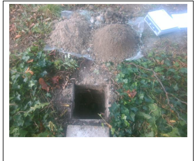
Foto: Inspectiegat A02
