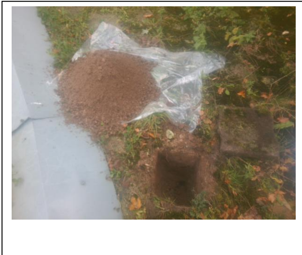
Foto: Inspectiegat A03
