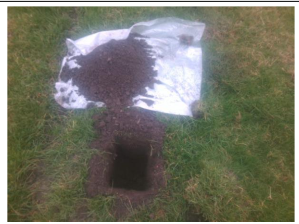
Foto: Inspectiegat B16
