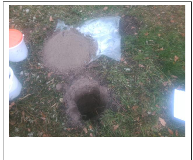
Foto: Inspectiegat C16
