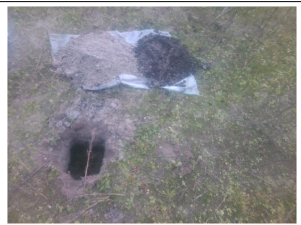
Foto: Inspectiegat D08
