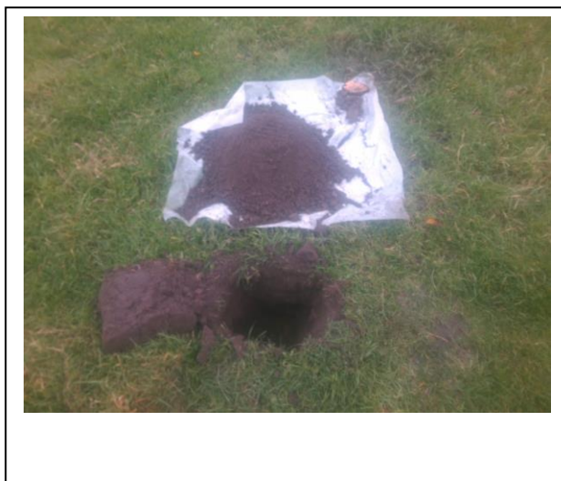
Foto: Inspectiegat B06
