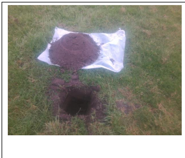
Foto: Inspectiegat B02
