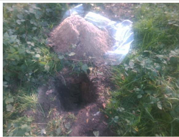
Foto: Inspectiegat C30
