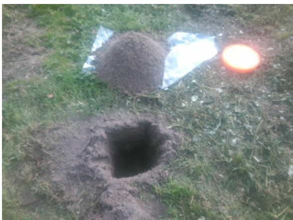
Foto: Inspectiegat C25
