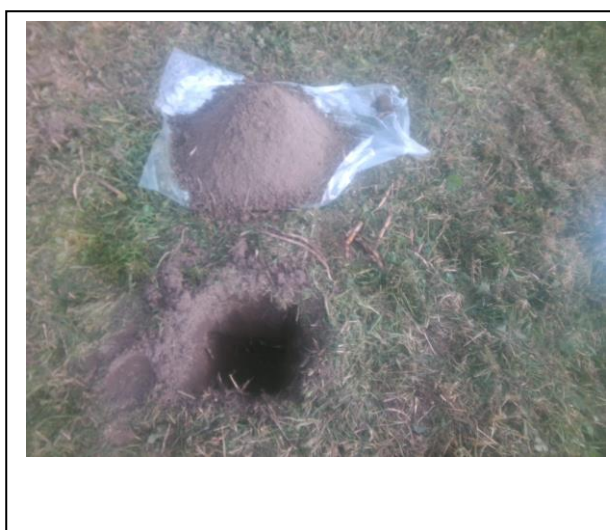
Foto: Inspectiegat C24
