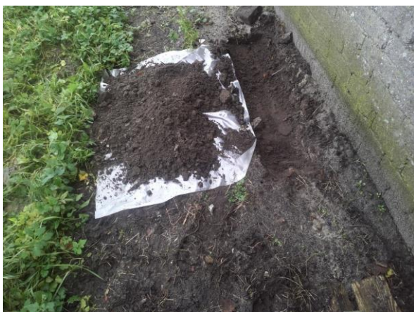
Foto: Inspectiegat A07
