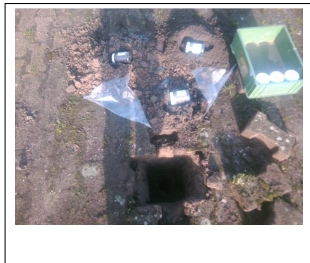
Foto: Inspectiegat A02
