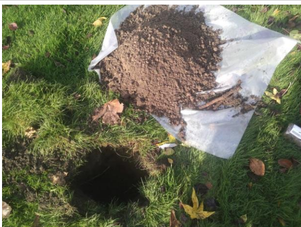
Foto: Inspectiegat B03
