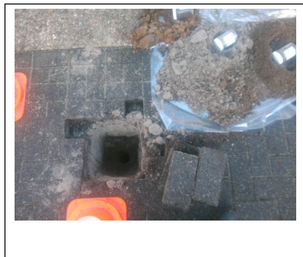
Foto: Inspectiegat A06
