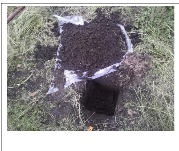
Foto: Inspectiegat C03
