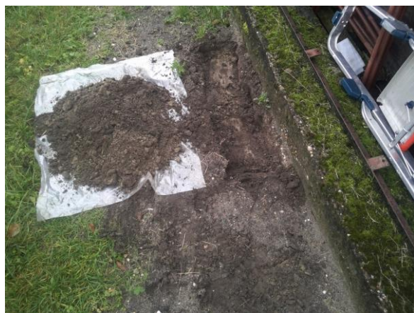
Foto: Inspectiegat A08
