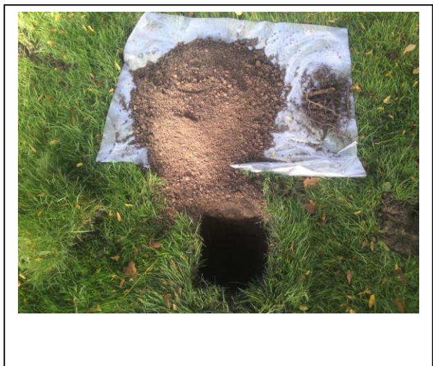
Foto: Inspectiegat B06
