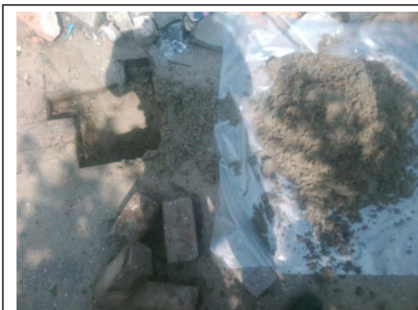
Foto: Inspectiegat E125 (7-50 cm -mv)
