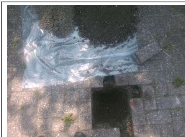
Foto: Inspectiegat E129 (20-50 cm -mv)
