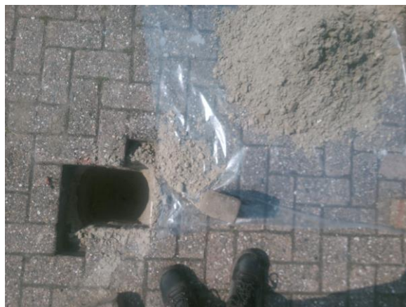
Foto: Inspectiegat E128 (7-50 cm -mv)
