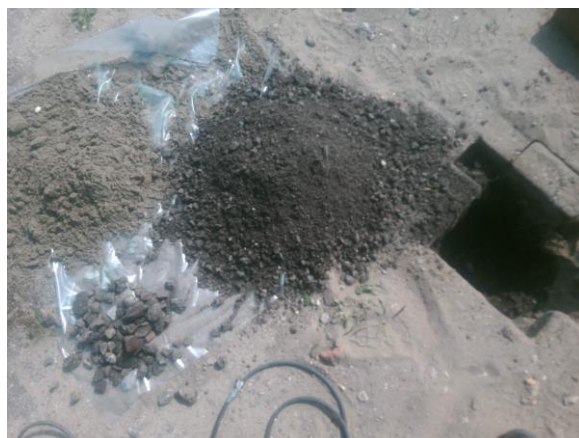
Foto: Inspectiegat E126 (7-50 cm -mv)
