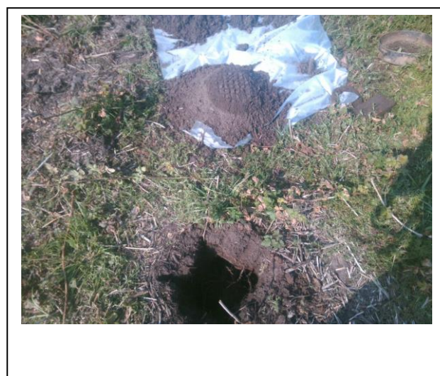
Foto: Inspectiegat F2-01
