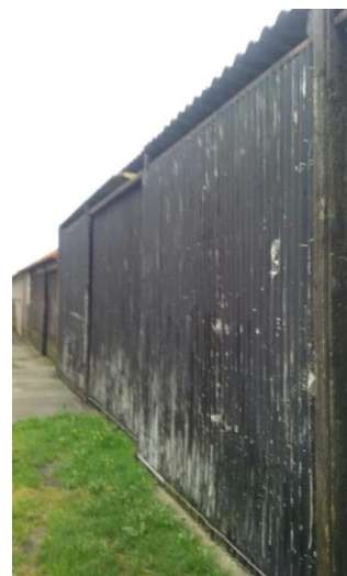
Foto 5 Afwatering asbestdak buiten onderzoekslocatie
