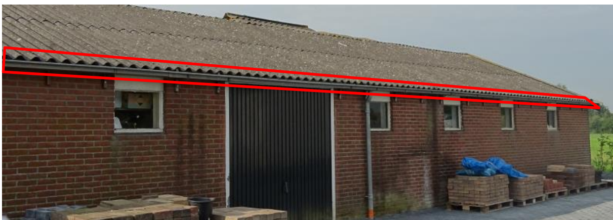
Figuur 5.1. Potentieel geschikte nestplaats voor huismussen; dakgoten met mogelijkheden onder de dakplaten (rood omrand).
