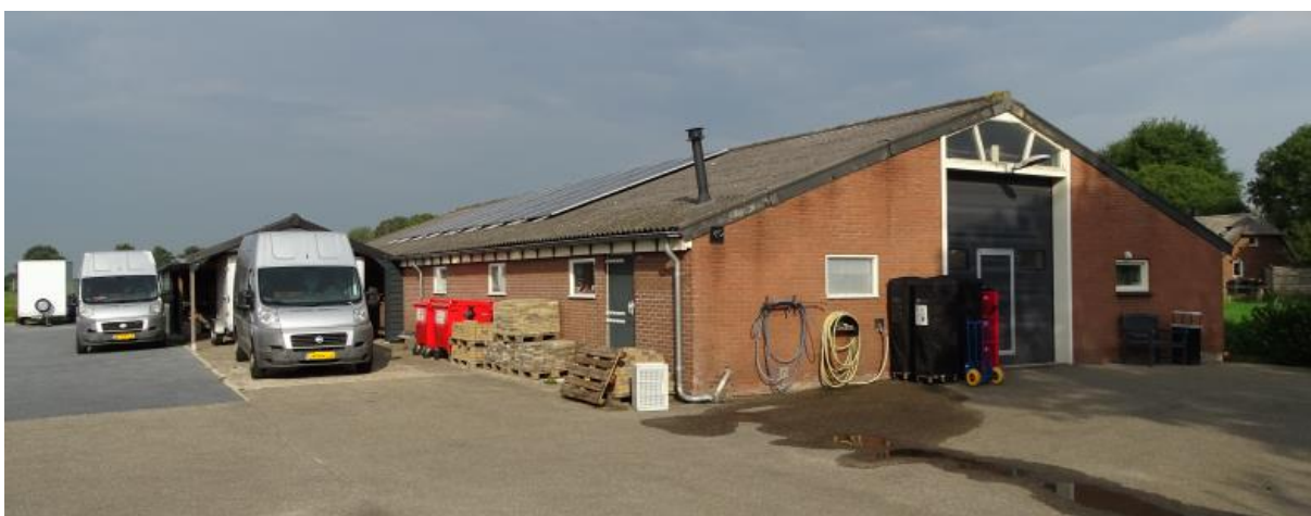
Figuur 2.4. Voormalige varkensschuur en carport, dienen eveneens als opslag (dak wordt vervangen).
