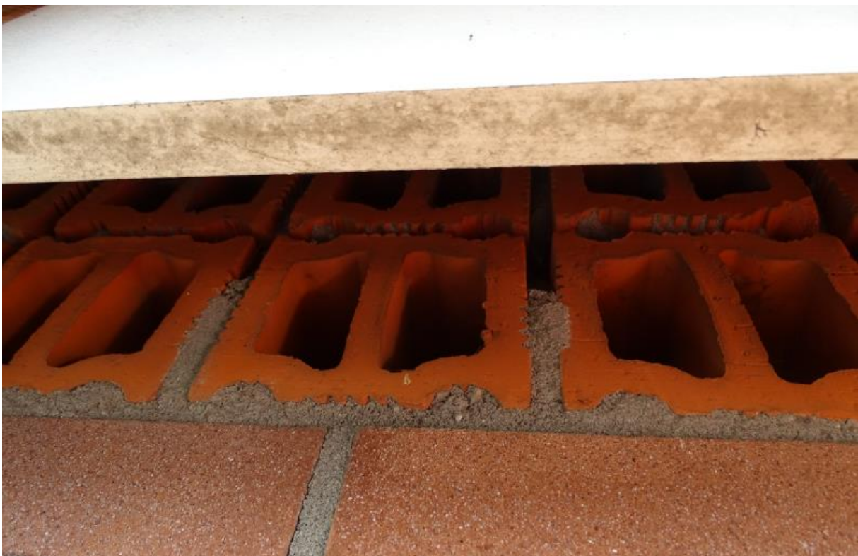
Figuur 5.6. Ventilatiestenen onder de witte boeirand onder de dakgoot bieden een potentiële toegangsmogelijkheid voor vleermuizen.
