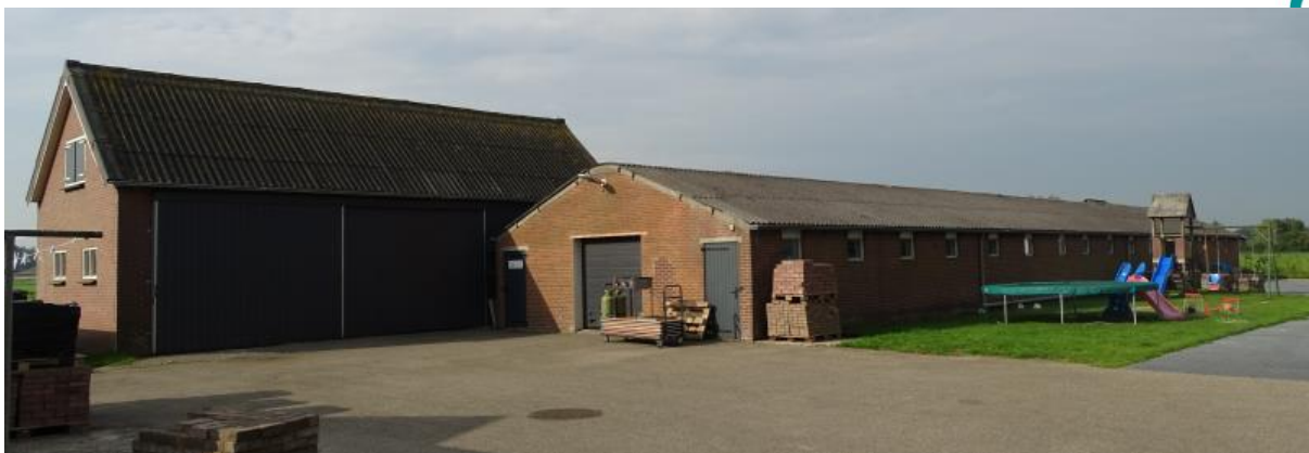
Figuur 2.2. Voormalige varkensschuur en bijgebouw, beide dienen nu als opslag en worden gesloopt.
