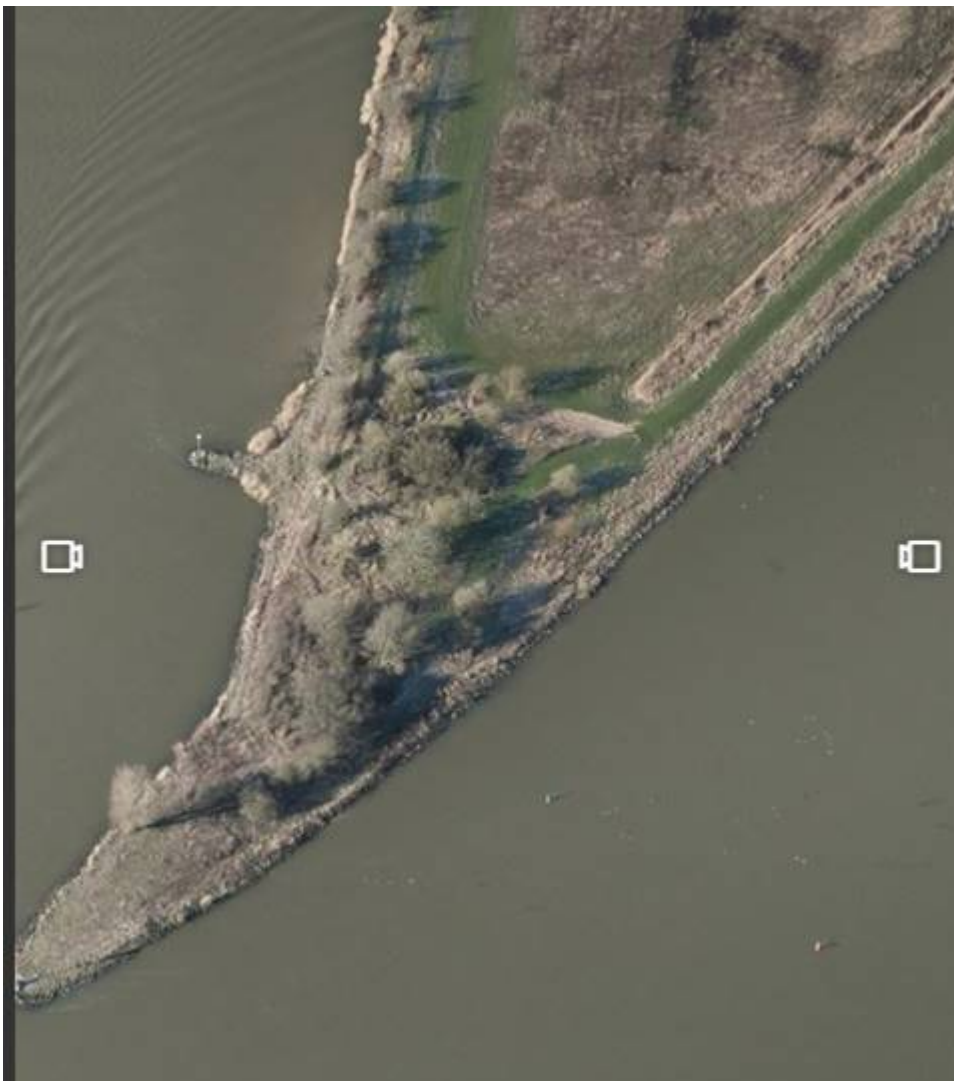
Afbeelding: Bestaande situatie oostelijk deel Keteleiland
