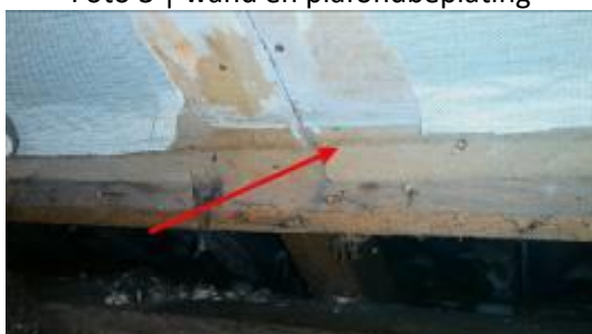
Foto 5 | wand en plafondbeplating
