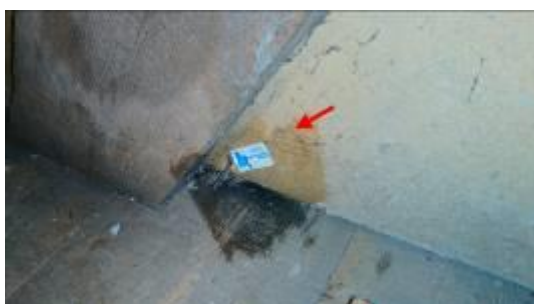
Foto 3 | wand en plafondbeplating
