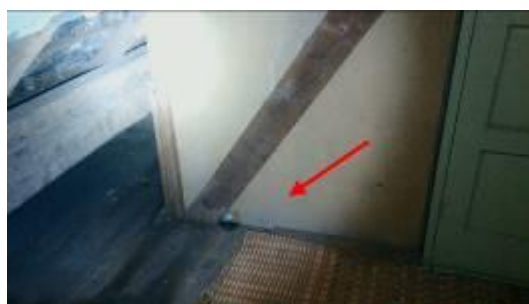
Foto 4 | wand en plafondbeplating
