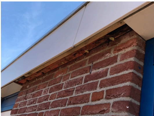
Diverse opening en kieren langs de aftimmering van het gebouw
