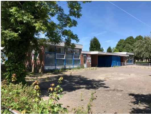
Voorzijde voormalig schoolgebouw
