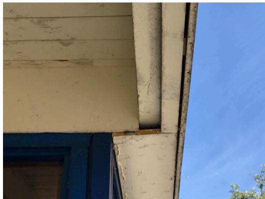
Diverse opening en kieren langs de aftimmering van het gebouw
