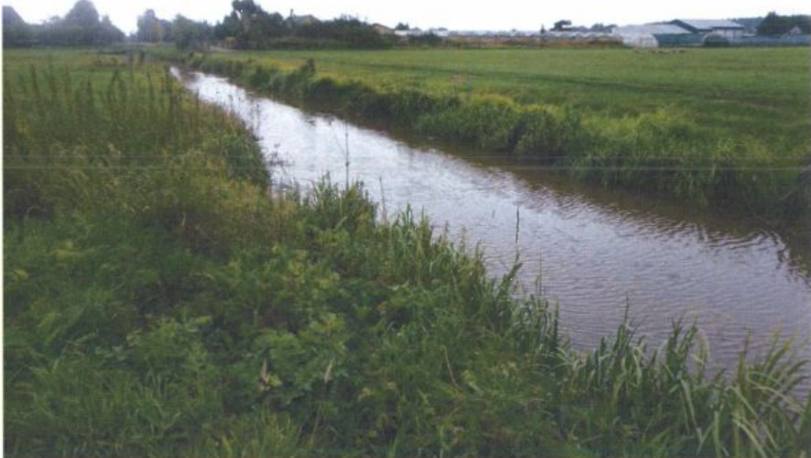
Figuur 2.4. Overzichtsfoto watergang in de richting van de Tuindersweg.
