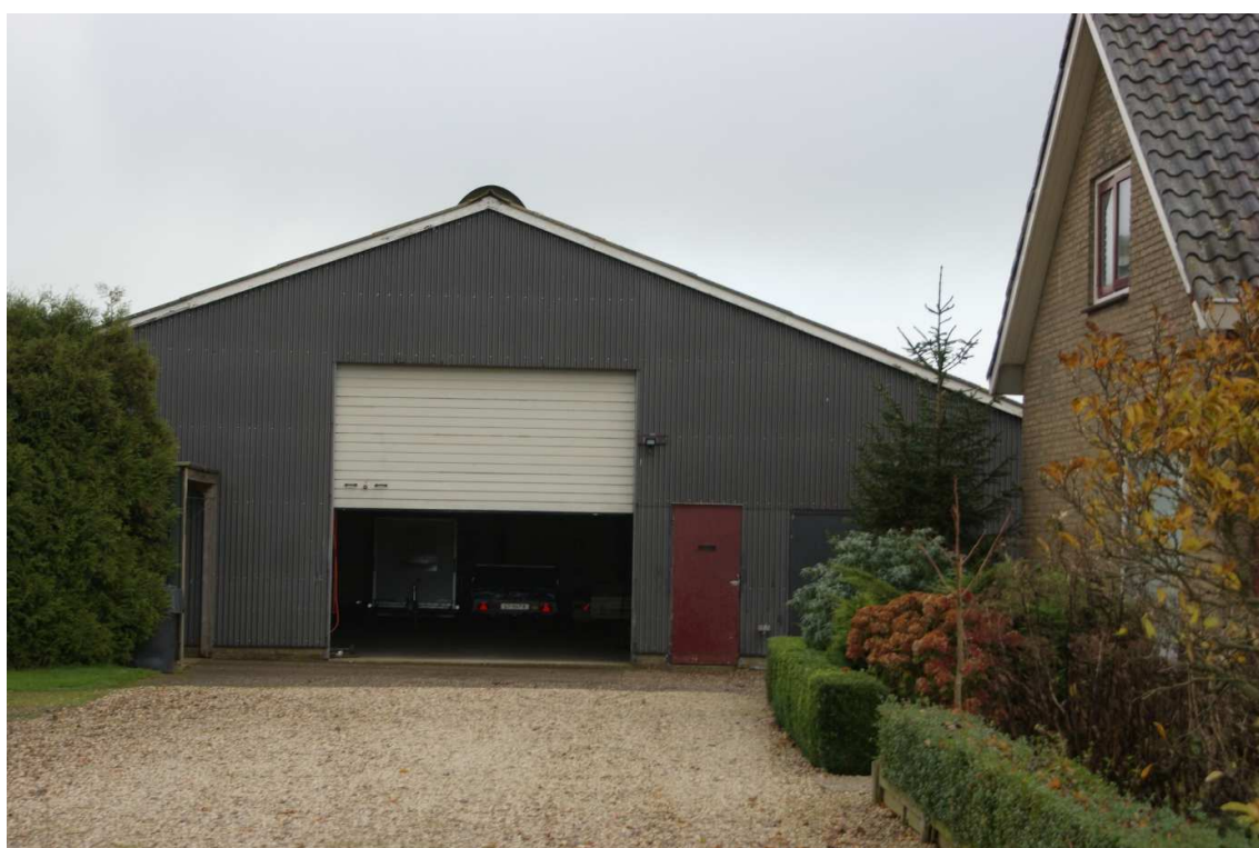
Figuur 2.3. Voorkant van de te slopen loods
