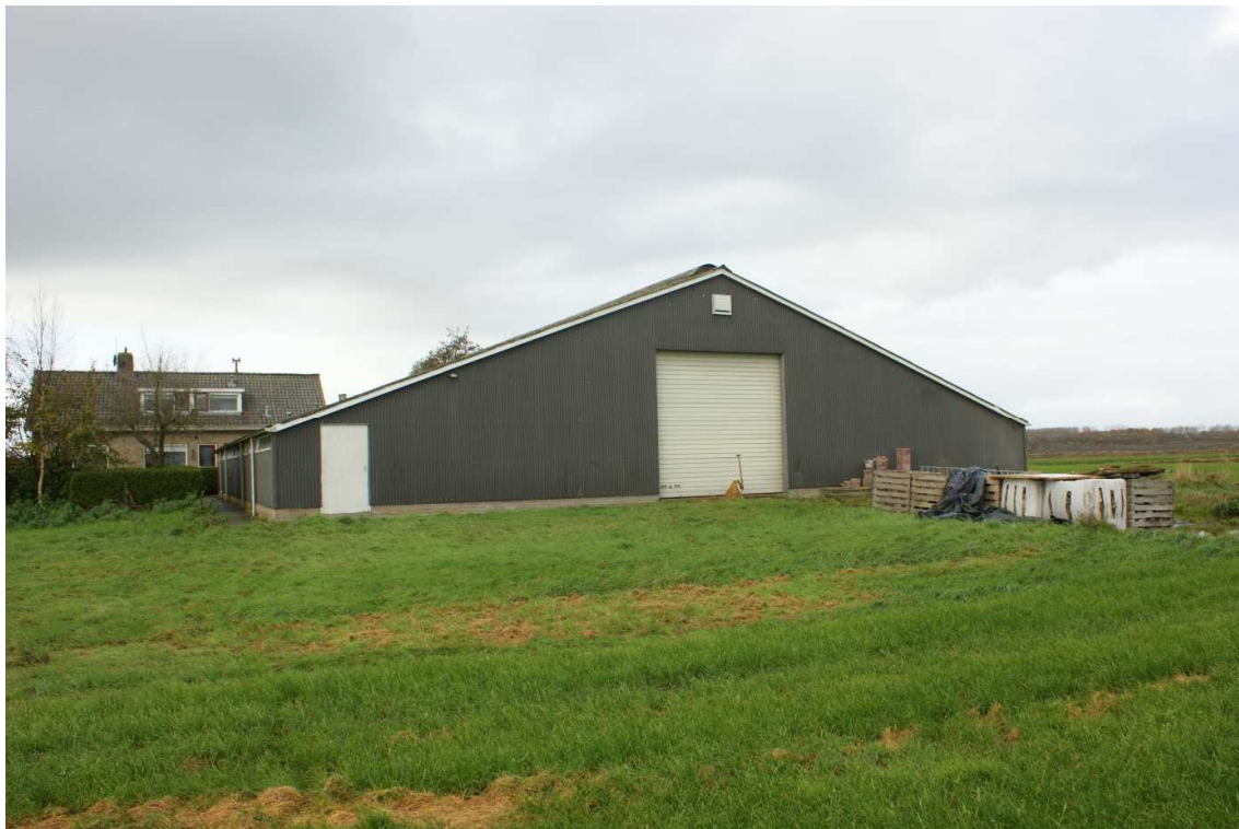
Figuur 2.5 Achterkant loods
