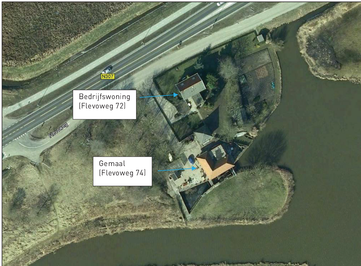
Figuur 1: Luchtfoto van het gemaal en de bedrijfswoning
