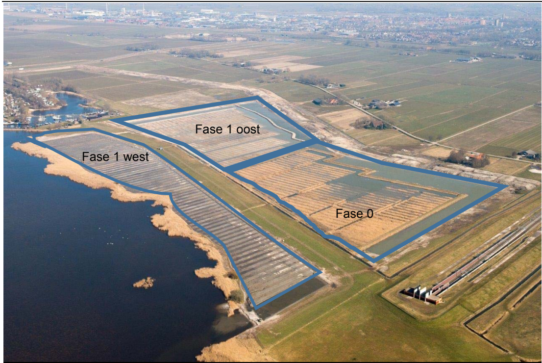
Fasering aanleg rietmoeras
