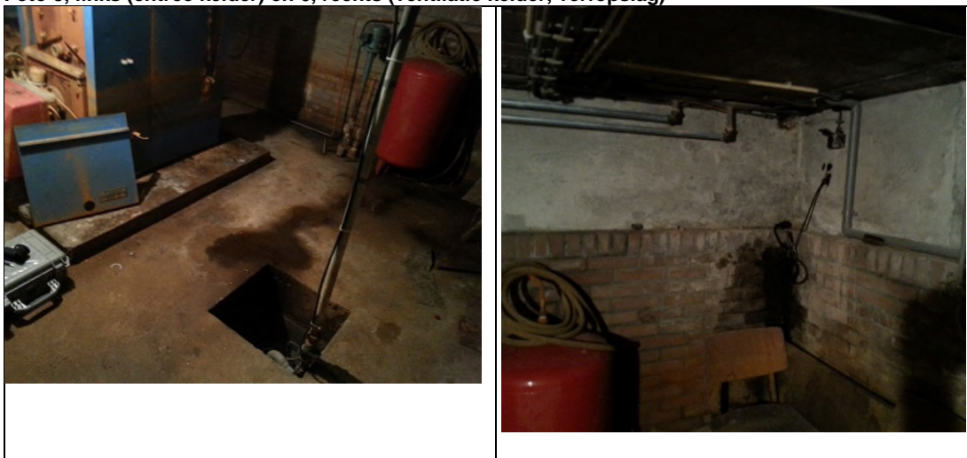
Foto 5, links (entree kelder) en 6, rechts (ventilatie kelder, verfopslag)
