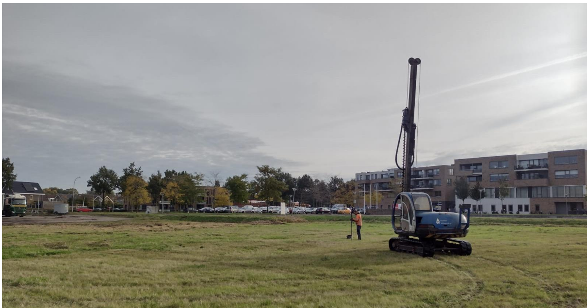
Figuur 4. Mechanische avegaarboor tijdens het onderzoek.
