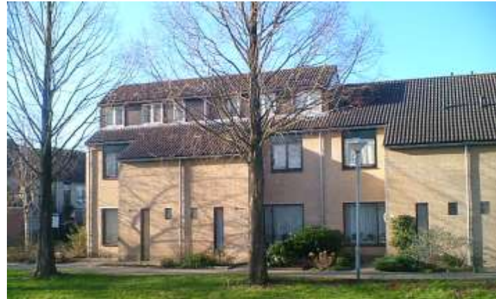
Bij de bouw meeontworpen dakopbouwen aan de voorzijde van het dakvlak
