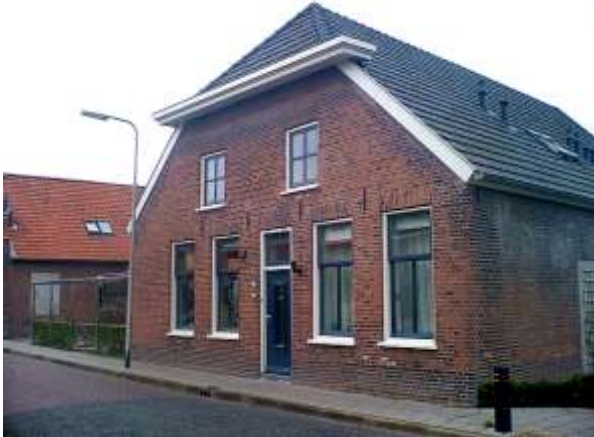
Oude boerderijbebouwing aan Sint Nicolaasdijk
