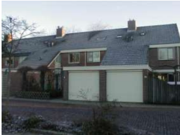
Garages/bergingen voor de voorgevel
