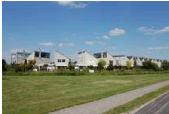
Woningbouwcluster aan de Henk Steenbeekhof
