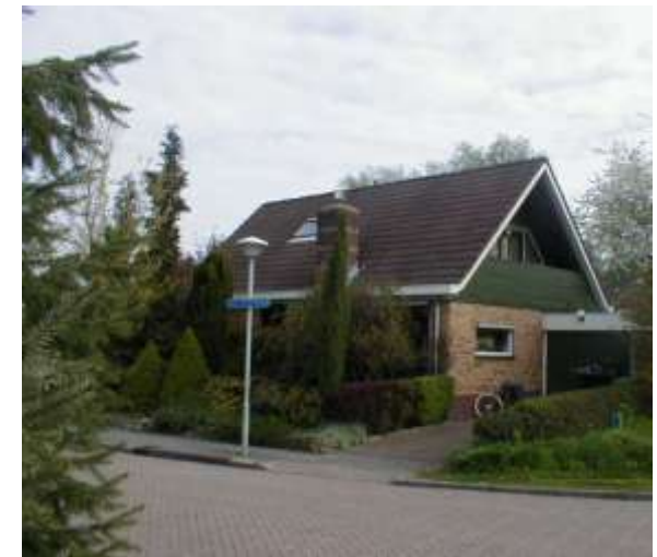
Later toegevoegde kap met inwendig balkon
