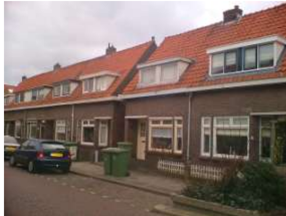
Koopwoningen met zadeldak
