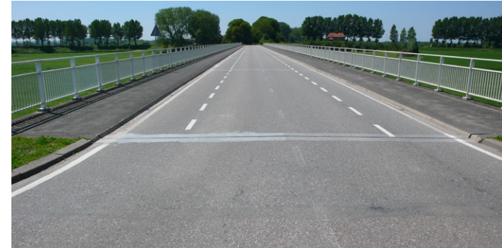
Helder en rustig wegprofiel zonder rommelige obstakels
