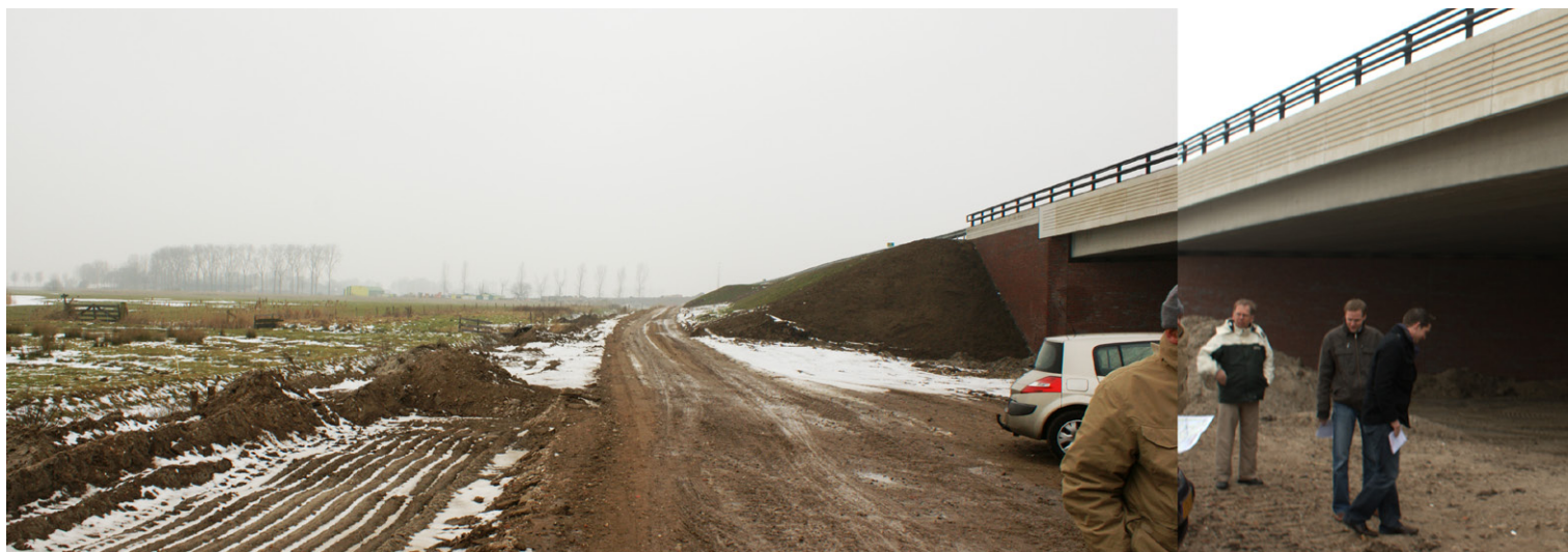
Reeds aangelegd viaduct van de N50 (zelfde type als viaduct Hanzelijn)
