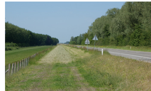
Bestaande situatie Drontermeerdijk
