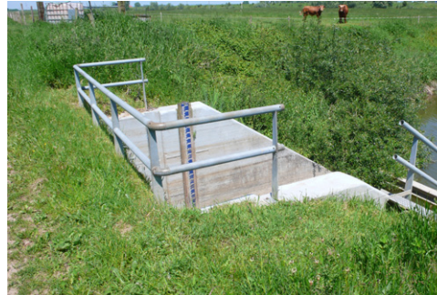
Betonnen wanden volgen talud
