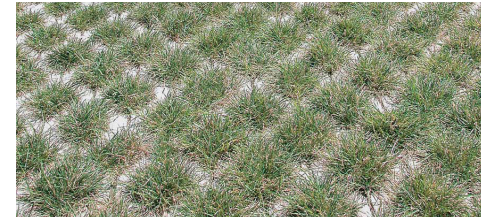
Referentiebeeld geperforeerd beton, toe te passen voor de beheerspaden buiten de instroomopening.
