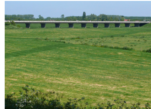
Het dijktaalud loopt ongehinderd onder de brug door. Geen hiërarchie in de kolommen
