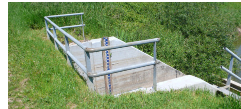
Betonnen wanden volgen talud
